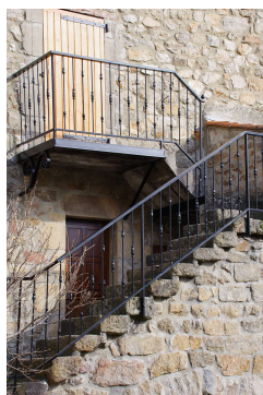
Garde-corps de balcon et d'escalier (Arlebosc)
