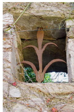
Grille de fenestrou (Naves)
