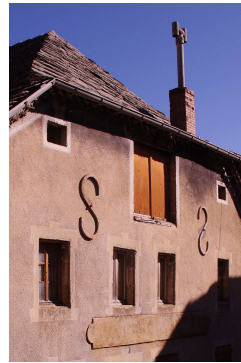
Tirants de façade (St Martial)
