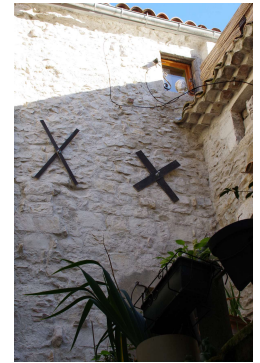
Tirants de façade (Viviers)
