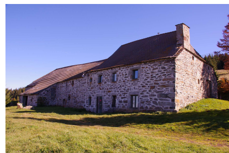
Façades Sud et Ouest d'une maison isolée sans ouvertures (Le Béage)
