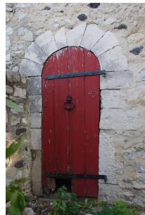
Ouverture en cintrée (St Thomé)
