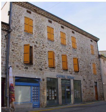
Cas d'une façade ordonnancée (Vernoux en Vivarais)
