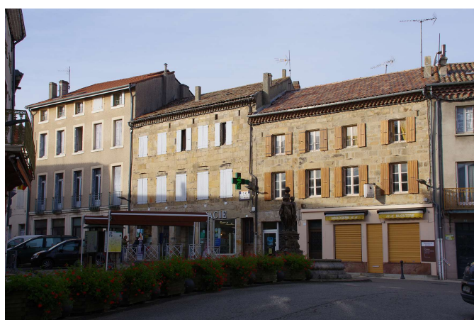
Façades de bourg ordonnancées (Vernoux en Vivarais)
