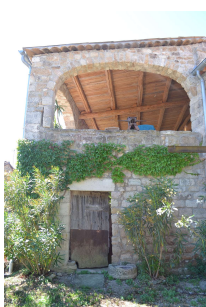
Ouverture terrasse (Payzac – Le Barsac)
