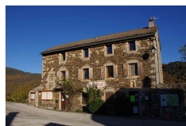
Façade ordonnancée (Sablères)
