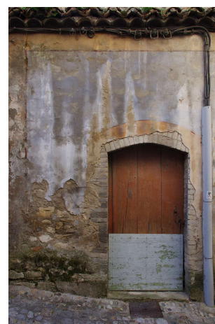
Façade ancienne peinte (Viviers)
