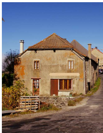
Toit à pignon rehaussé (Le Béage) Localisation : La Montagne
