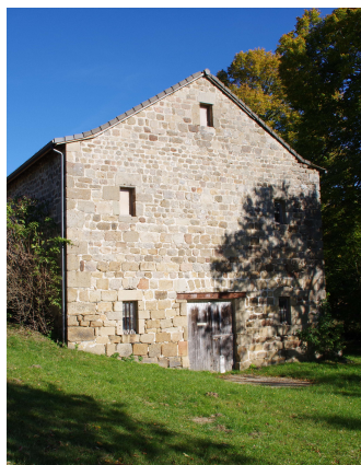
Toit à « Coyau » (St Agrève) Localisation : La Montagne
