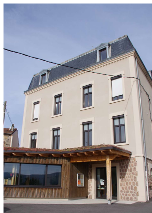
Toit « à la Mansard » (Vernoux en Vivarais) Localisation : zone urbaine, bâtiment singulier
