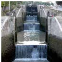
LES 9 ÉCLUSES DE FONSERANES SUR LE CANAL DU MIDI
