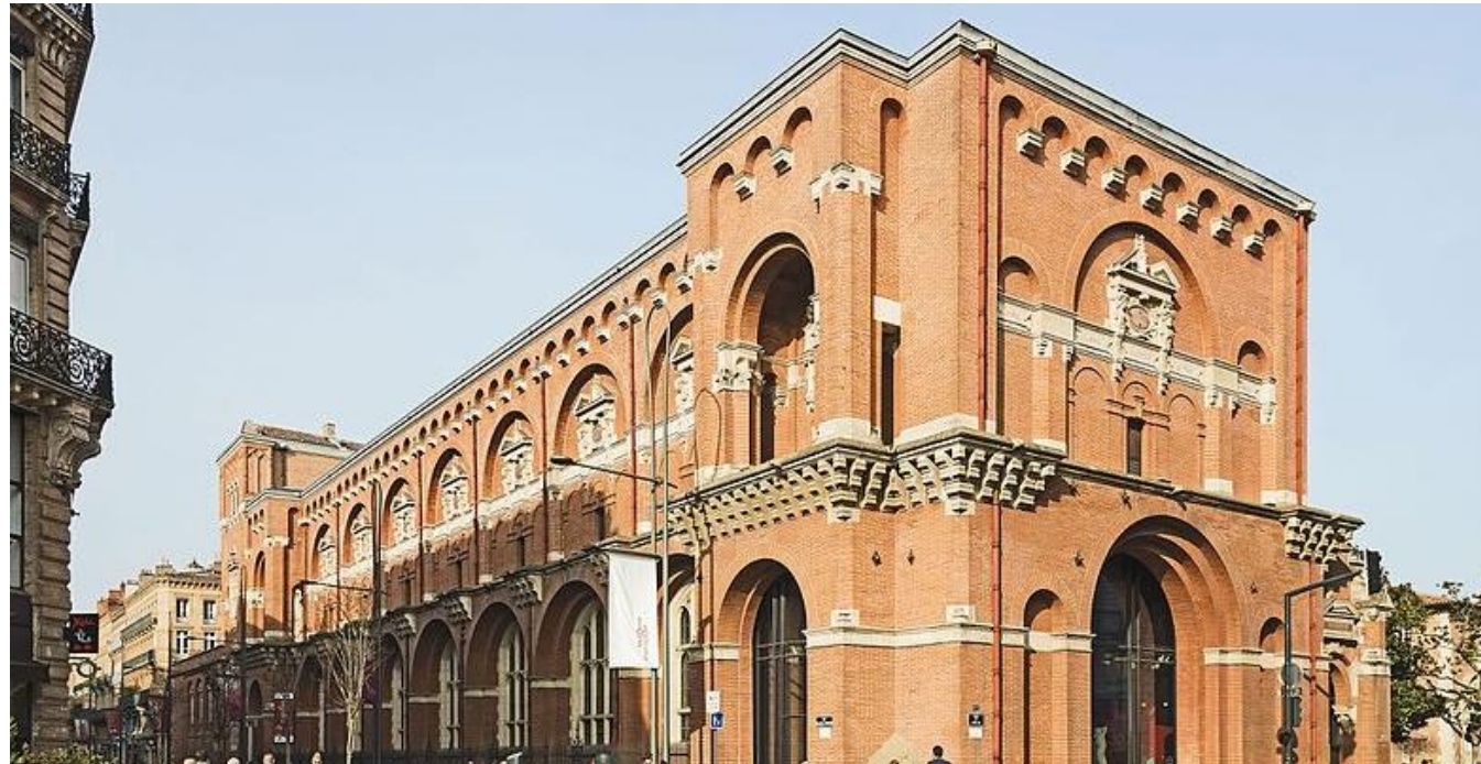
Les travaux au musée des Augustins se poursuivent
