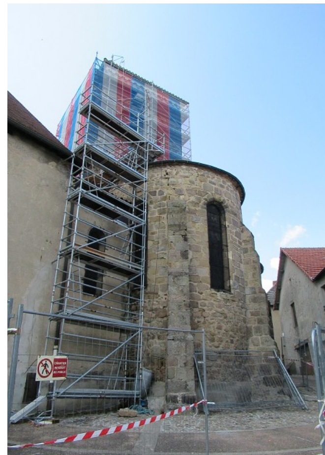
En phase chantier
