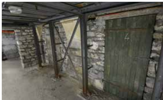
Dans un immeuble parisien, les caves font l'objet d'un confortement par la mise en place d'un plafond métallique supporté par des poutrelles. Les accès se font par des portes étanches aux gaz.
