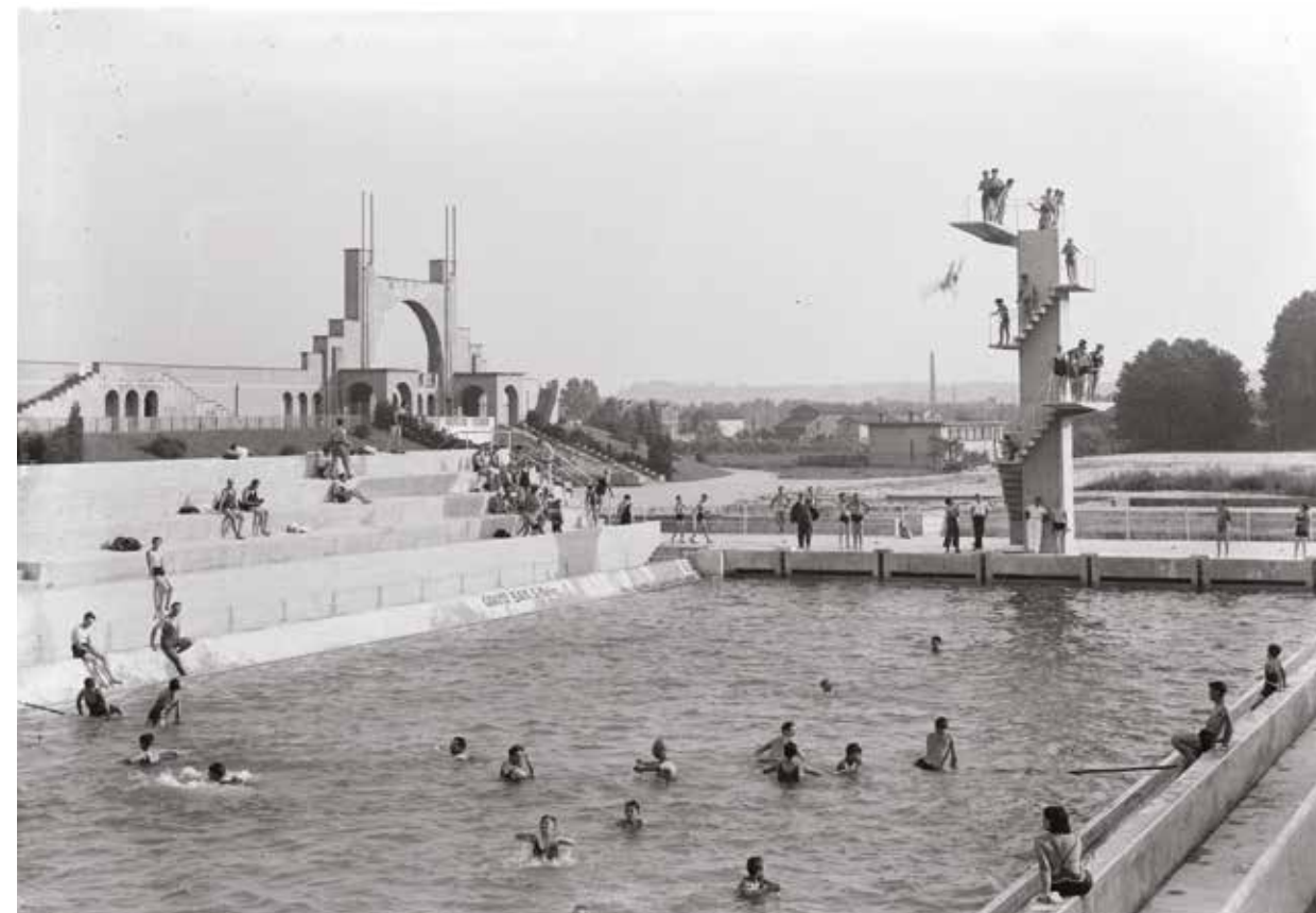
[2] La piscine du stade municipal de La Mouche, dit stade de Gerland, photographie sur plaque de verre, 1935 (Lyon, Archives municipales, 15PH/1/352).
