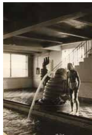
[2] La piscine de l'ASM du site sportif de Montlosier, créé en 1919 à Clermont-Ferrand par l'entreprise Michelin, et sa fontaine en béton (Archives Michelin). Nunc est bibendum .
