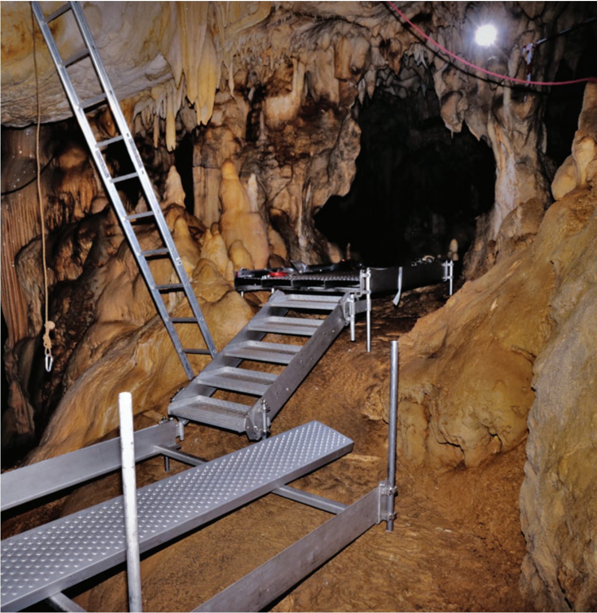
[3] Salle Brunel, descenderie, état des travaux en 1988.
