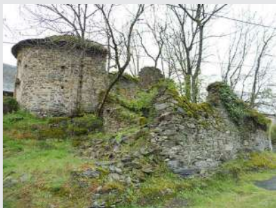
L'église en ruine dans le village d'Argut-Dessous, © Clément Venco
