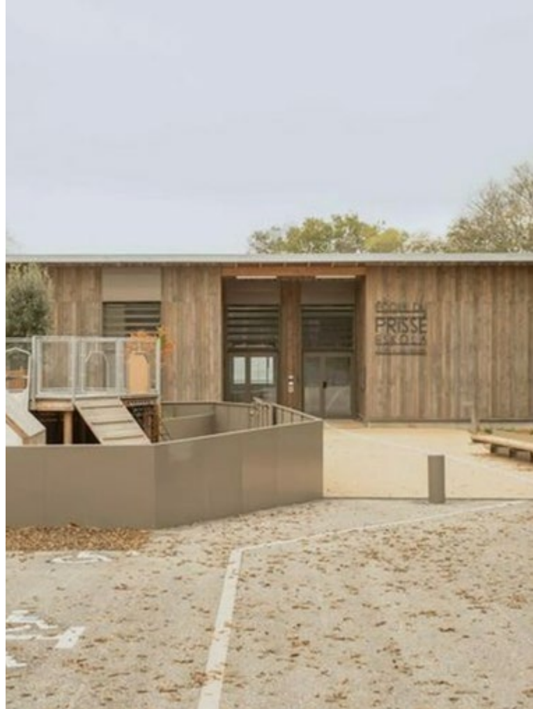
Groupe scolaire du Prissé à Bayonne Pyrénées-Atlantiques
