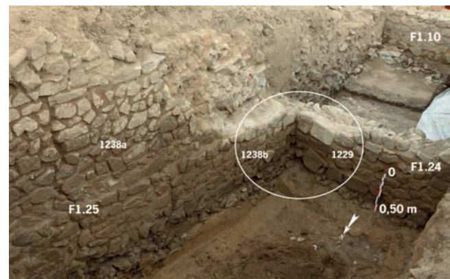
Élévations conservées dans le sondage 1 (cl. M.-H. Jamois)
