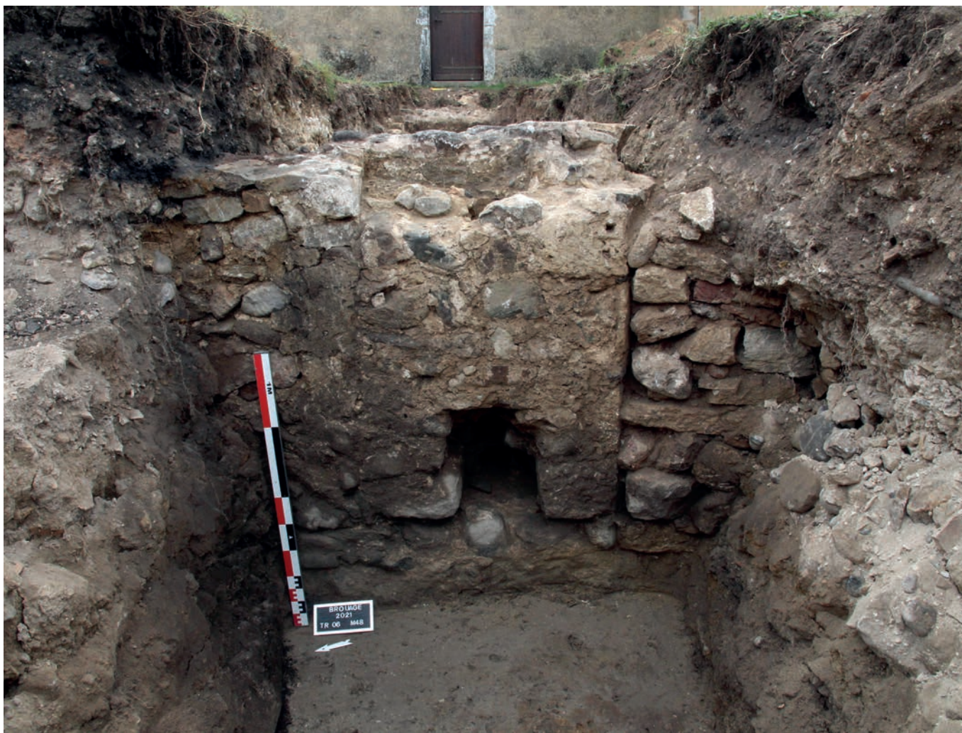
Marennes, Hiers-Brouage, le mur M 48 appartenant au cellier et ses différents états de bouchage. On remarque le trou communiquant avec une aération verticale aménagée dans l'élévation du mur (cliché : B. Gissinger).
