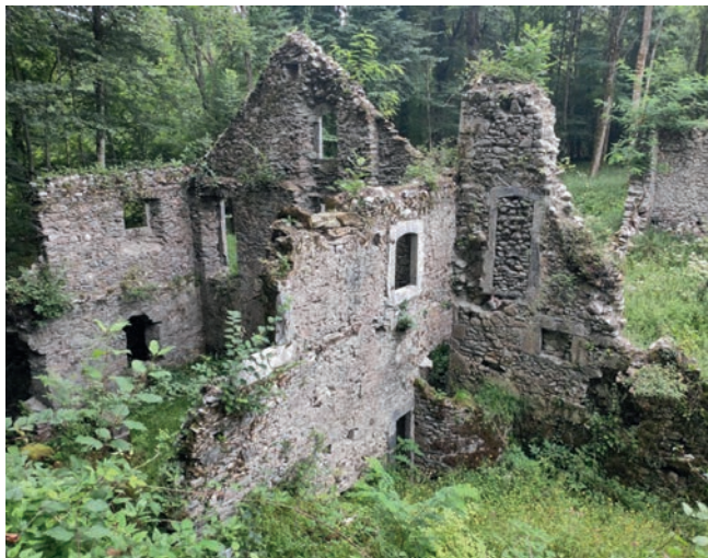
Vue des bâtiments de la forge d'Arthez-d'Asson (photo : Ch. Ars).
