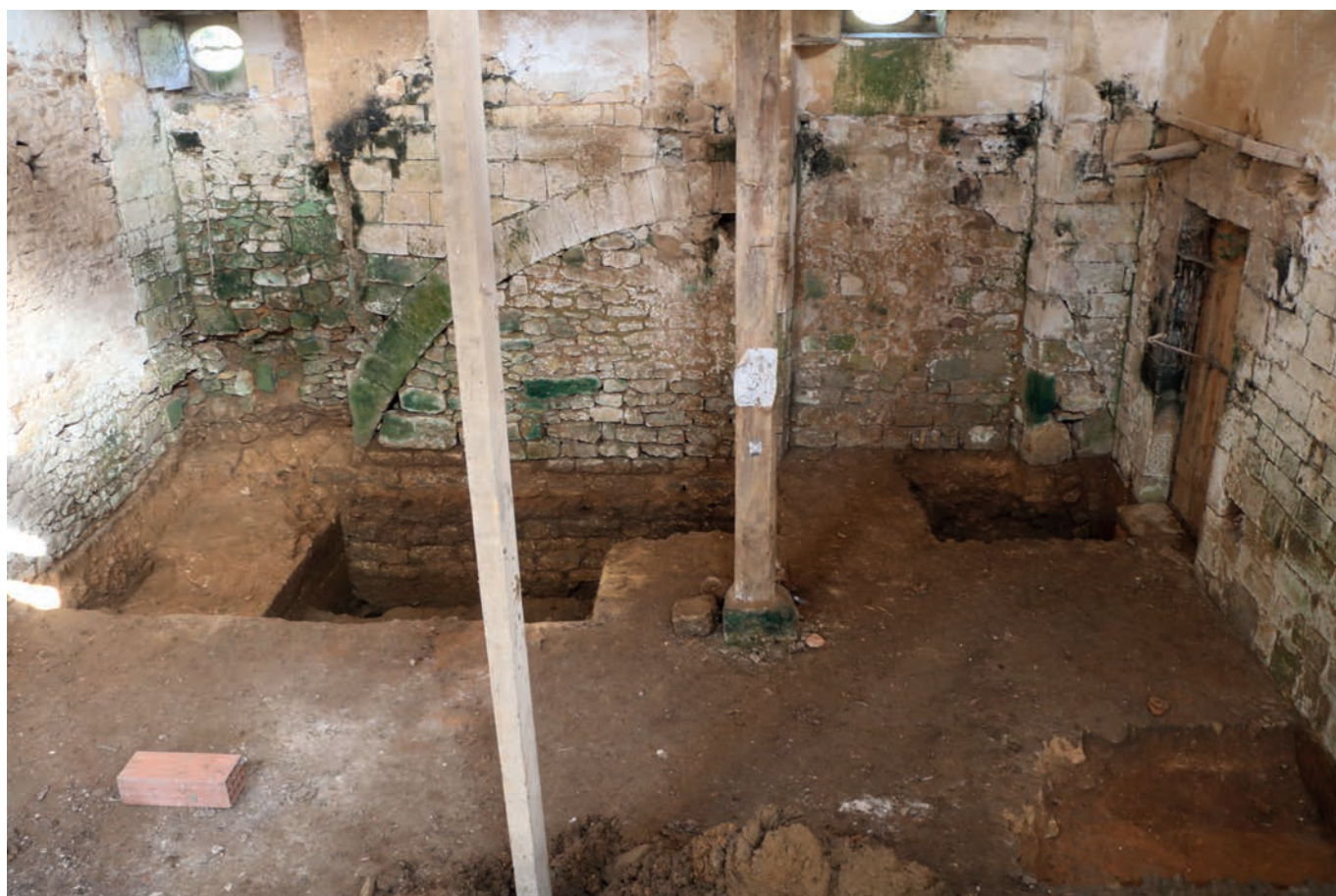
LE BUISSON-DE-CADOUIN - Abbaye de Cadouin. Vue générale des sondages 1 et 2 à l'extrémité du bâtiment est de l'abbaye de Cadouin (© J.-B. Javel).
