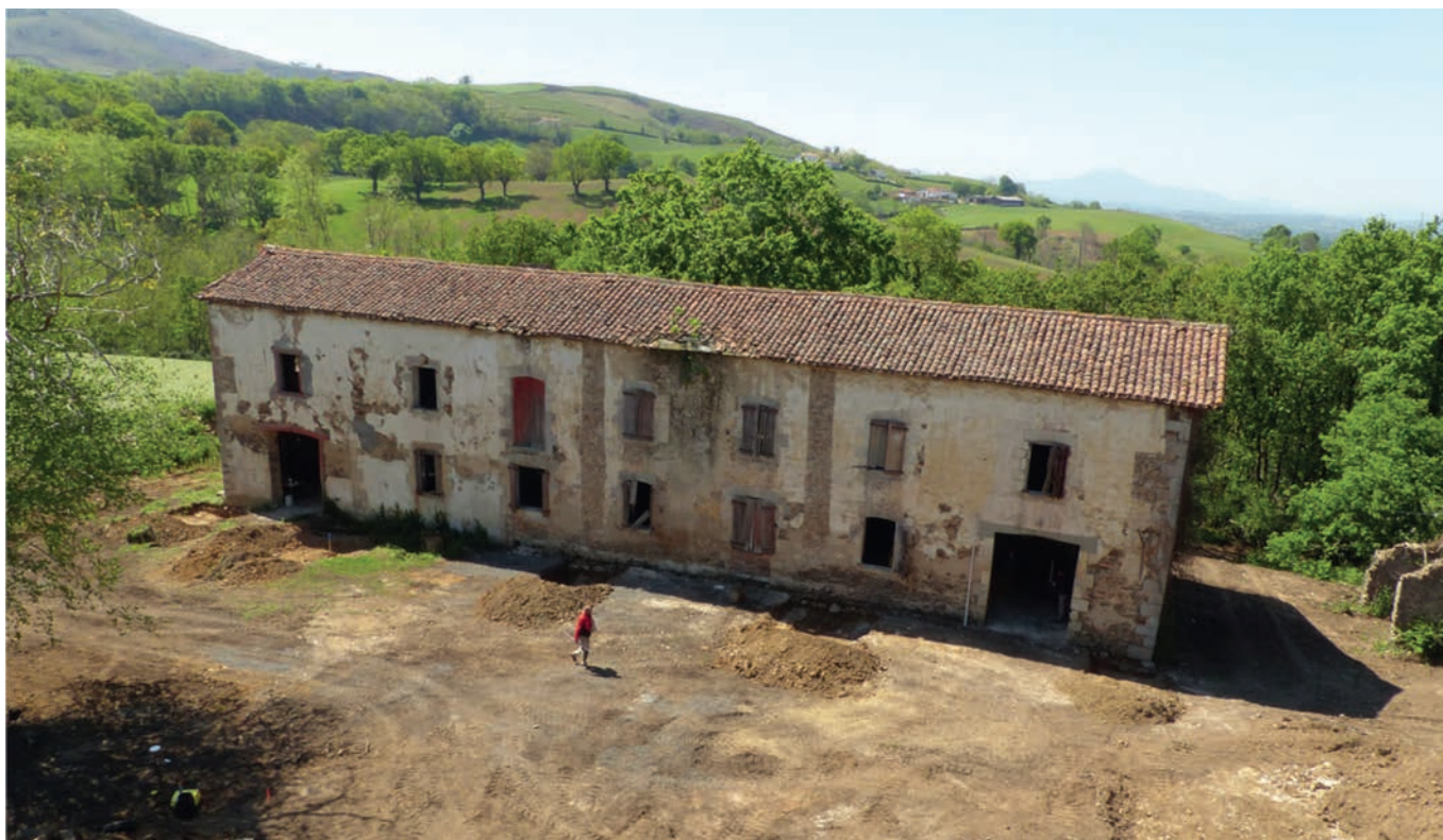
HASPARREN - Chemin Celhay - Zalduya. Vue de la façade est du bâtiment (photo © V. Pasquet, Inrap).
