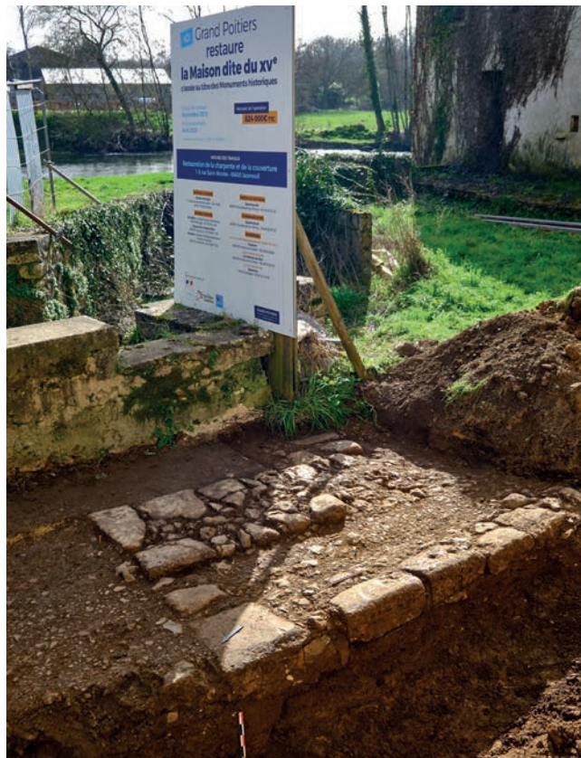
Jazeneuil, rue Saint-Nicolas, fig.4 : Détail des maçonneries MR2, MR3 et MR4 mises au jour à proximité de la fontaine (cliché : Ch. Belliard)
