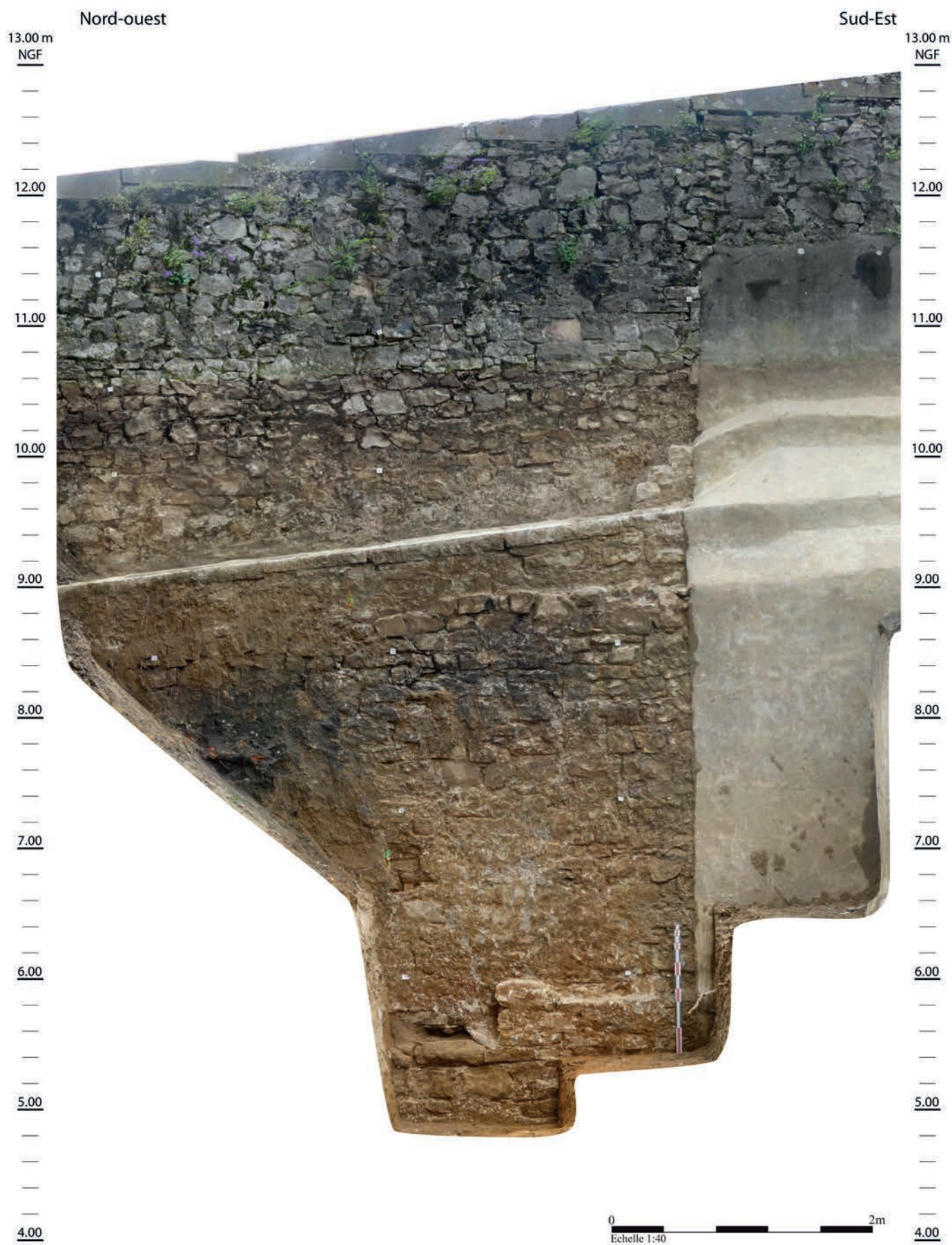
BAYONNE - Casemates de Mousserolles. Vue du parement interne de la courtine des Capucins après fouille (Clichés et DAO Q. Baril, traitement photographique S. Malpelat, Hadès, 2022).
