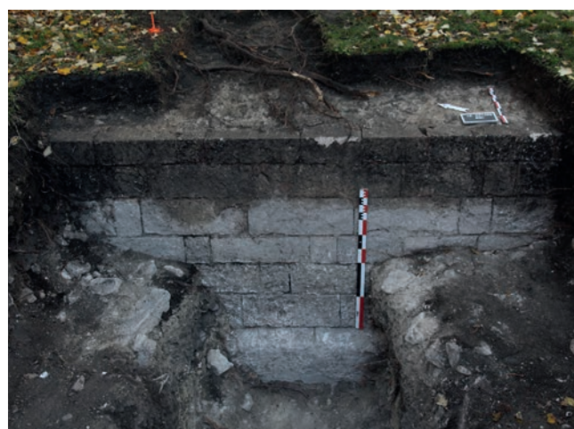
La Rochelle, place Pierre Sémart, boulevard Joffre, vue d'une partie de l'élévation du parement de l'ouvrage à cornes de Tasdon (cliché : B. Gissinger)
