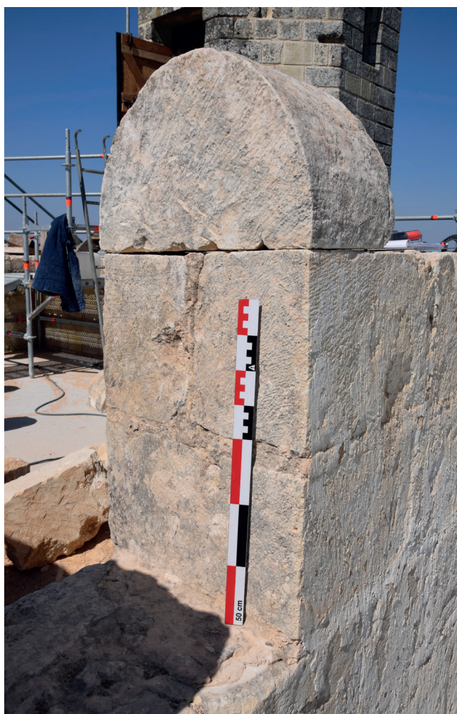
Vellèches, Château de Marmande, fig.2 : Merlon couronné de son chaperon (cliché J. Noblet).
