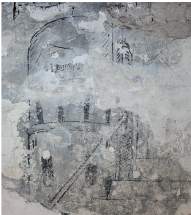
Poitiers, 27 et 29 rue des Carolus, 1 et 3 rue Arthur-de-la-Mauvinière, fig. 3 : Détail des peintures à la grisaille décorant les murs du rez-de-chaussée du bâtiment 3 (E. Marot – Atemporelle) en 2020 et 2021 (DAO : A. Diméglio).
