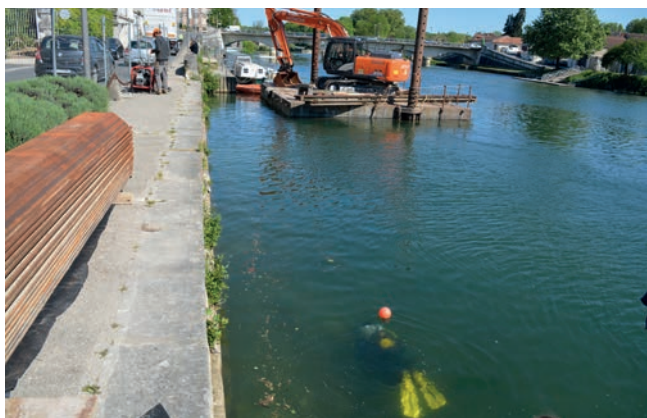
Jarnac, fleuve Charente, fig.1 : Archéologue-plongeur en prospection avant la mise en place des palplanches. (Cliché : J. Letuppe)
