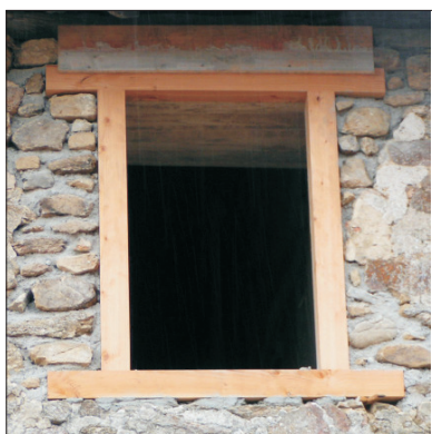
Pose de linteau en bois - chantier en cours
