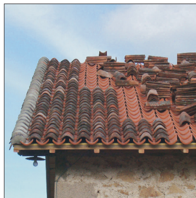
Pose de tuile canal traditionnelle
