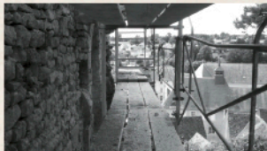
Chantier 2008 sur le grand mur du logis
