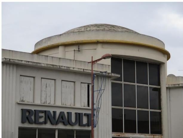
Le caractère novateur de l'architecture est résolument affirmé, en particulier par l'association de la monumentale vitrine et de ses massifs latéraux. Le garage est conçu pour plus de 20 voitures, avec un atelier de réparations automobiles et un dépôt d'essence avec trois réservoirs souterrain de 3000 litres chacun. La construction est réalisée en béton armé pour la partie exposition, en charpente métallique pour les sheds qui s'ouvrent à l'arrière.
