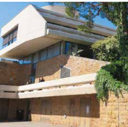
Lattes (Hérault), caisse régionale du Crédit agricole, avenue de Montpelliéret à Maurin, architectes Daniel Badani et Pierre Roux-Dorlut.
