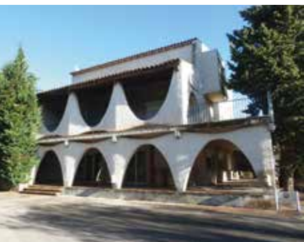
Castillon-du-Gard (Gard), la Compañie rhodanienne, hommage à Oscar Niemeyer, architecte Joseph Massota.
