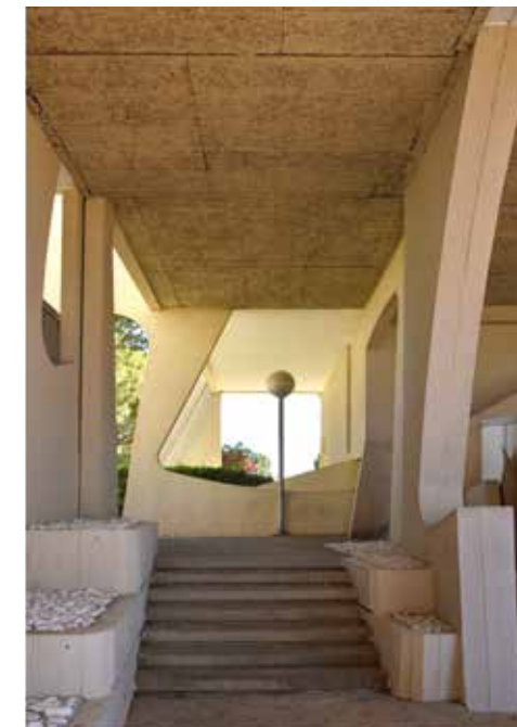
Le Grau-du-Roi (Gard), résidence Les Jardins du port, architecte Jean Balladur.
