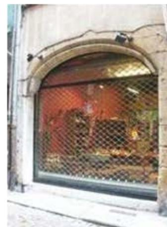
Exemple de volet roulant à l'intérieur
