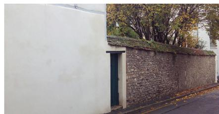
Pour sa pérennité, un mur doit être entretenu. Les joints, enduits, couvrements doivent être régulièrement nettoyés et restaurés si besoin. Un entretien régulier peut éviter par la suite des travaux structurels importants.
