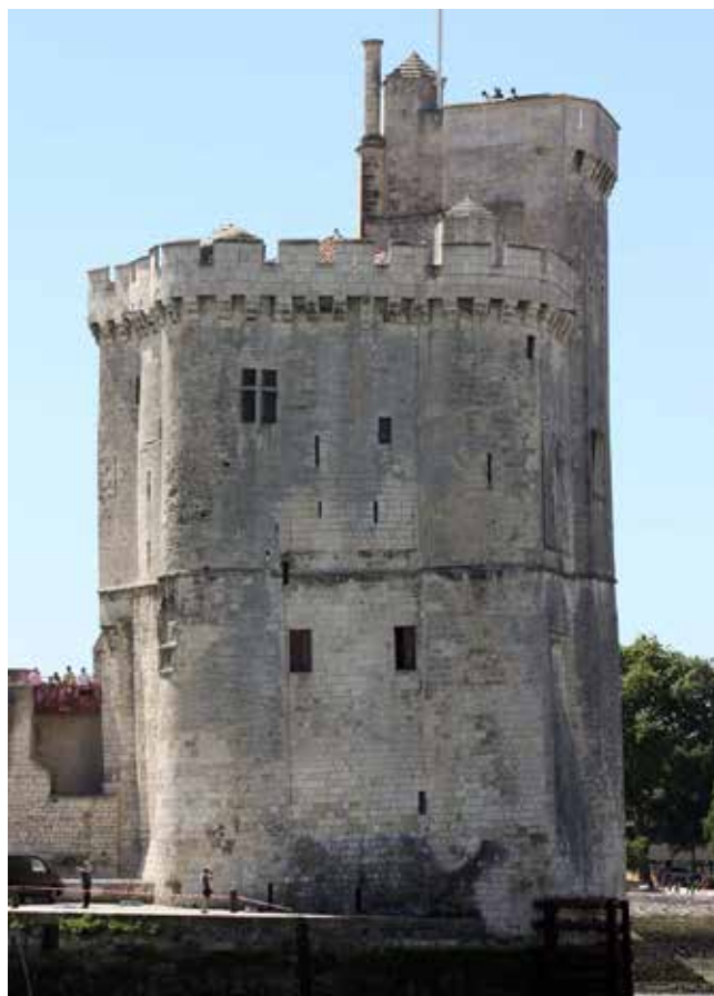
LA ROCHELLE, Tour Saint-Nicolas, façade nord (cliché : F. Boisserie)
