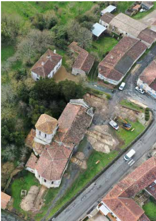
CHAMPAGNE, abords de l'Eglise Saint-André, vue générale du chantier par drone (Cliché : F. Brissonneau).
