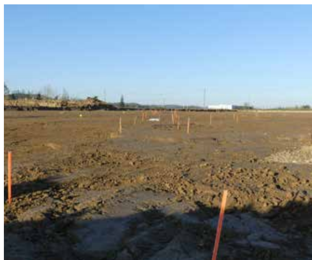
Vue générale vers le nord-ouest de la zone 1B prise dans l'axe du fossé ST40 après la phase de décapage (cl. : X. Bardot, Inrap)
