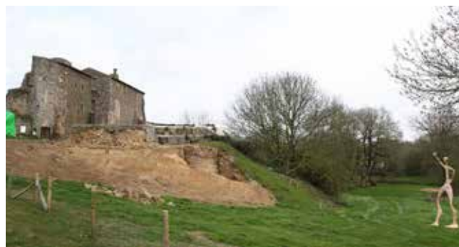
POUGNE-HÉRISSON, Château de Hérissou, fig. 1 : vue d'ensemble de la courtine sud et de la tour sud-est, en cours de dégagement (cliché : Fabrice Mandon)
