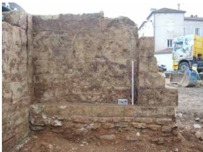
Fig.2 : parement nord du mur M38 de la tour romane (Cl. : N. Sauvaitre, Hadès, 2020)
