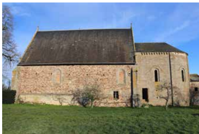
ARGENTONNAY, le château d'Argenton, fig. 1 : élévation extérieure sud de la chapelle (cliché : E. Marot)
