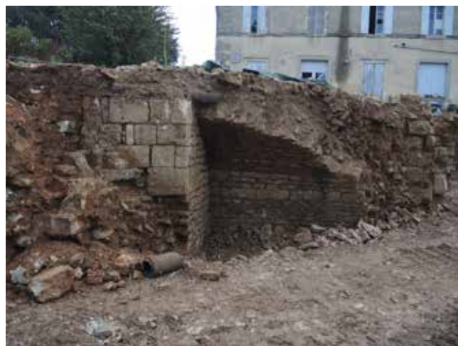
Fig.3 : Départ de voute aménagée sur le revers de la tour romane (Cl. : N. Sauvaitre, Hadès, 2020)
