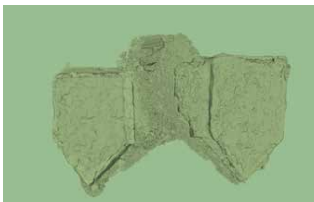
POITIERS, prospection thématique subaquatique sur les rivières de Poitiers fig. 1 : Vue du dessus des deux piles du pont du château de Poitiers et de l'arche brisée qui liait anciennement celles-ci après traitement photogrammétrique (traitement et rendu : J.-F. Mariotti).
