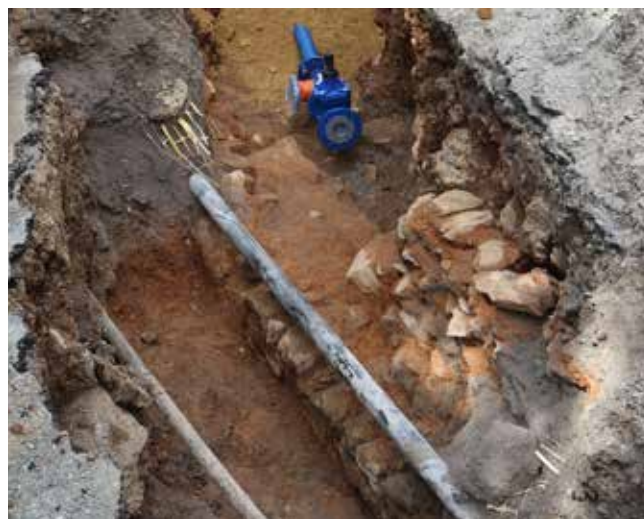
VOUNEUIL-SOUS-BIARD, rue du Moulin, fig.2 : Fondation d'un ancien mur aux abords du pont du moulin (cliché : E. Guilloteau)
