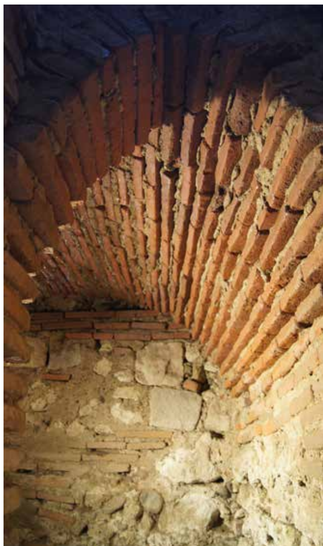
Fosse et départ du conduit vertical en briques (cl. : L. Soulard)
