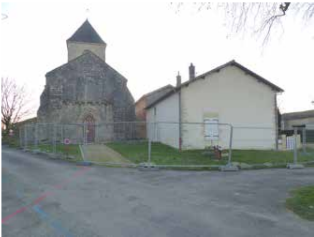
VANÇAIS, église Saint-Martin, Place des Platanes : vue générale de l'emprise du diagnostic, avec l'église Saint-Martin de Vançais (cliché : D. Martins)
