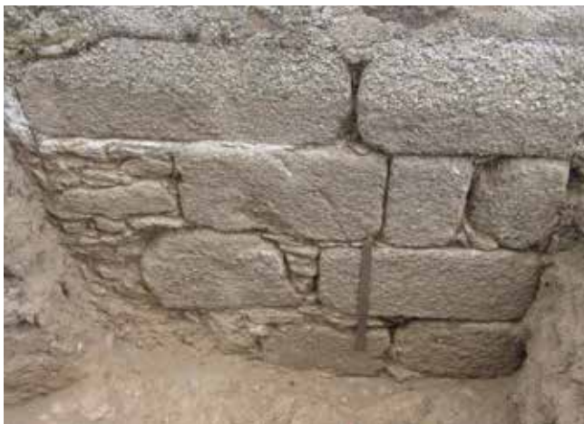
Saint-Léonard-de-Noblat - Chaîne d'angle d'un bâtiment dans le mur du cimetière (CSSL)
