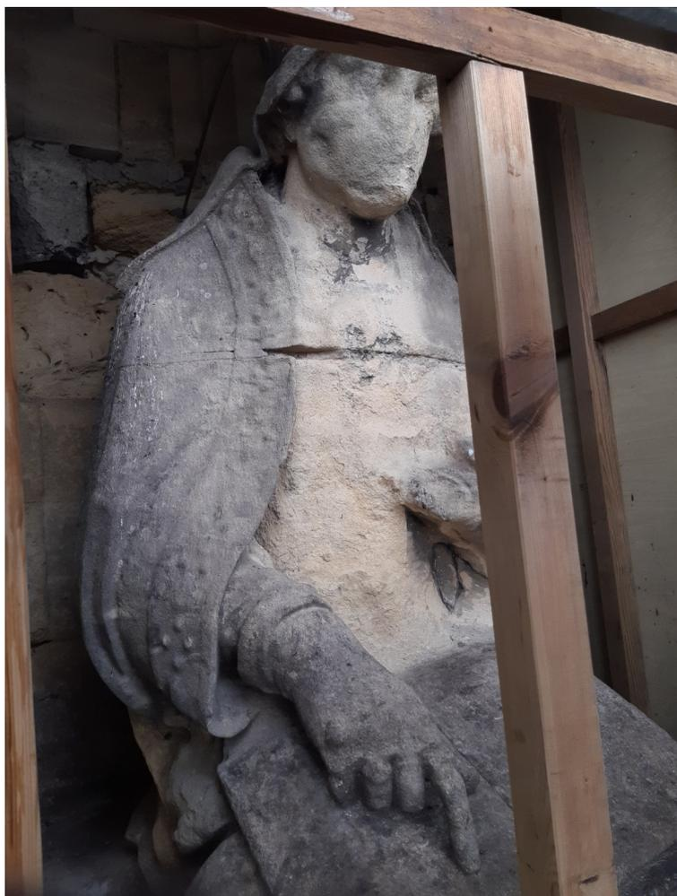
Les pierres attaquées par la végétation sont traitées puis nettoyées par cryogénie, un processus moins agressif pour le matériau qu'un nettoyage à l'eau (qui pose aussi un risque de projection sur les passants) mais tout aussi efficace. Pour les joints, ceux qui risquent d'aggraver la situation de la flèche sont repris et remplacés par des joints « souples » en chaux, faits pour suivre le mouvement de la flèche.
