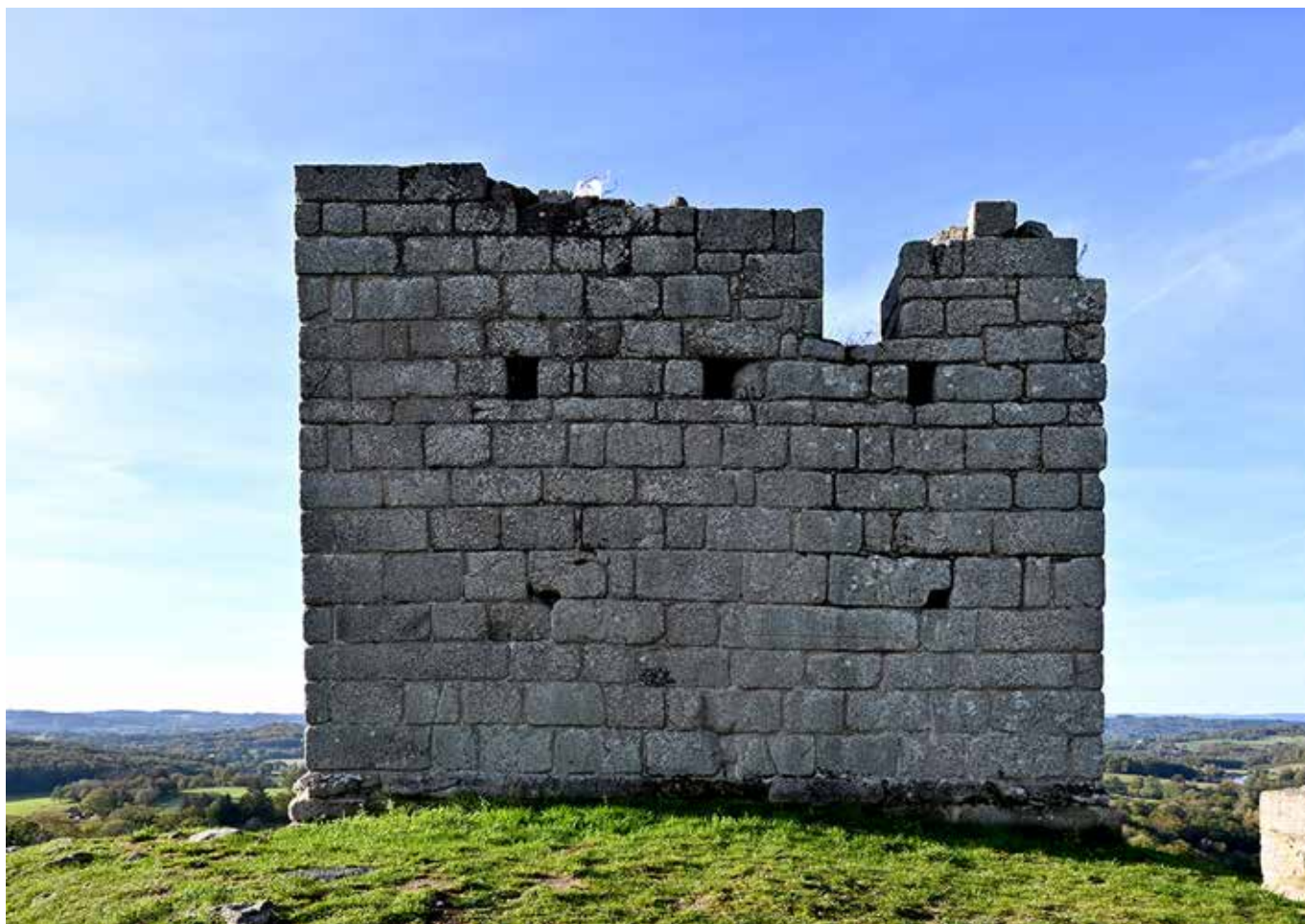
SERMUR - Façade nord de la tour (cliché D. Jouneau)
