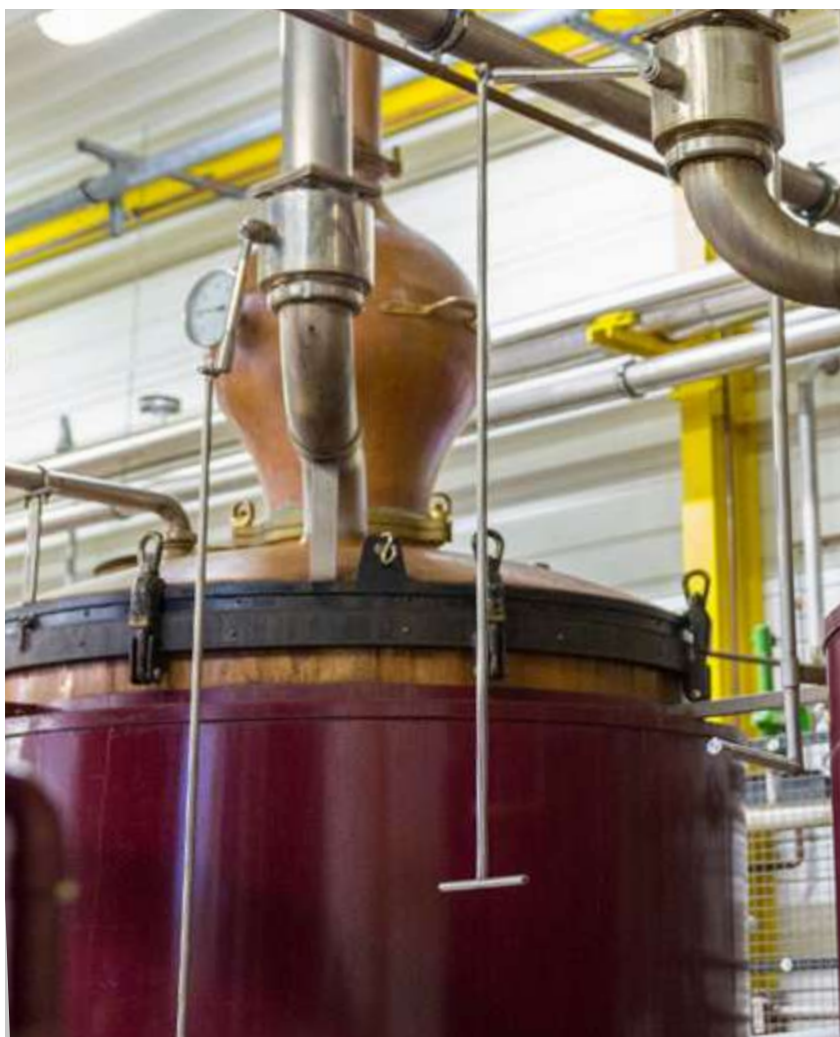
Distillerie des Terres Rouges, Turenne (19)
