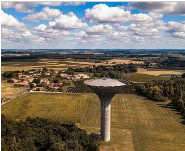
Château d'eau d'Asnières-la-Giraud (17)
