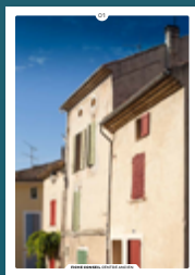
01 les façades enduites
