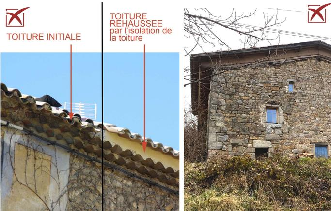
Rehausse de toiture par remplissage maçonnerie qui dénature les proportions de la génoise (St Montan)
