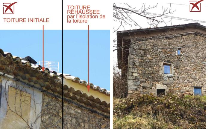
Rehausse de toiture par remplissage maçonnerie qui dénature les proportions de la génoise (St Montan)
