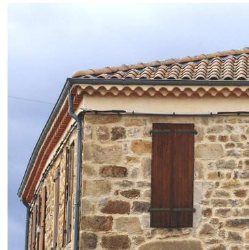
Rehausse de toiture par un bandeau maçonné et reconstitution de la génoise (Arlebosc)
