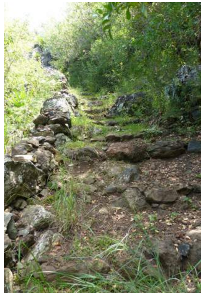
[Fig. 4]: Chemin 3, emmarchements vus vers le nord (photo T. Cornec / Inrap)
