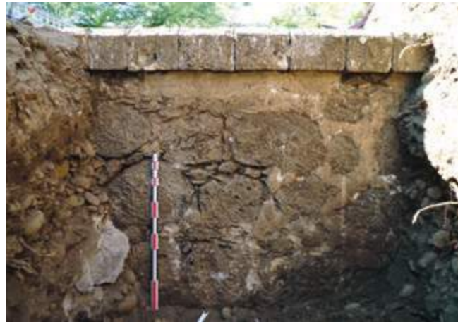
[Fig. 4]: Vue de détail du parement du quai Usc 10 du sondage 3 (photo F. Gerber / Inrap)
