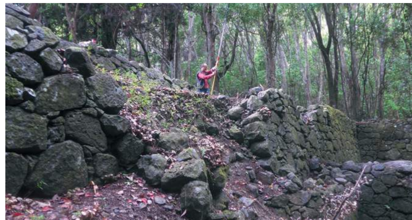
[Fig. 3]: Orthophotographies des murs de terrasses (photo T. Comec / Inrap)
