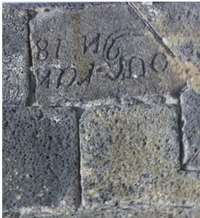
[Fig. 4]: Bloc avec inscription provenant du premier état de la Redoute réintégré lors de la transformation en magasin à poudre et replacé à l'envers (photo M.-C. Gineste / Inrap)
