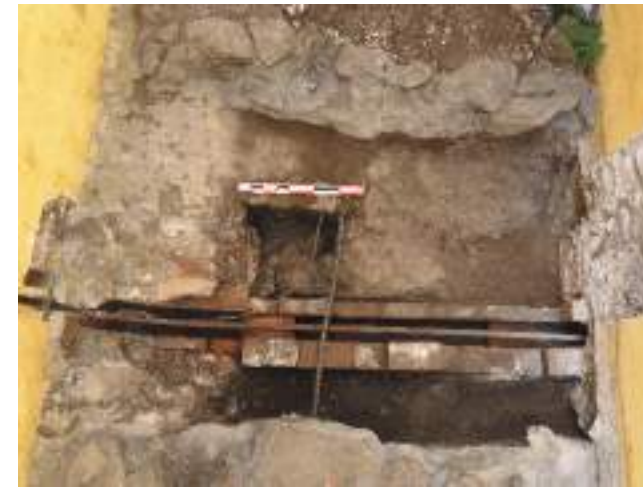
[Fig. 3]: Vue du conduit du paratonnerre dans la cour (photo J. Cornec / Inrap)
