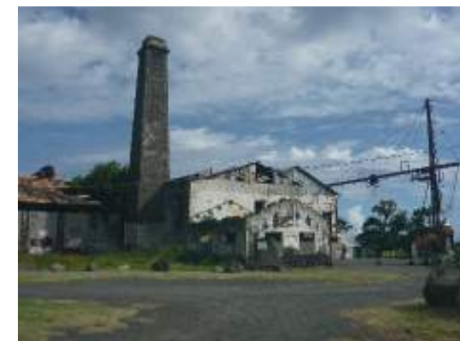
[Fig. 2]: Vue de certains bâtiments conservés et d'une grue de l'usine, au moment du diagnostic (photo D. Rigal / Inrap)
