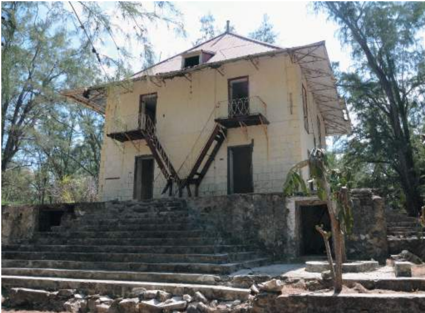
[Fig. 4]: Vue de la façade principale de la maison Herscher, anciennement appelée maison Paturau, depuis le sud-sud-est (photo P. Brial)
