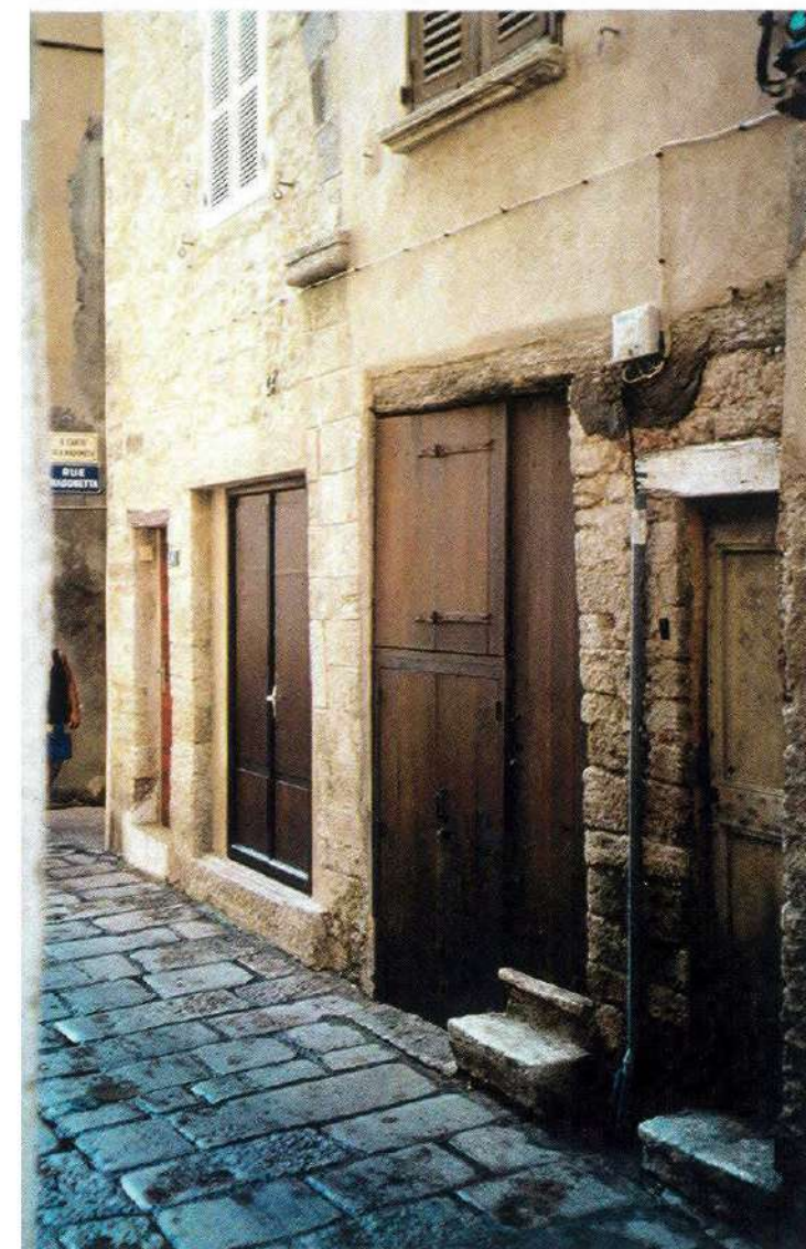
Bon exemple de menuiserie à rez de chaussée
