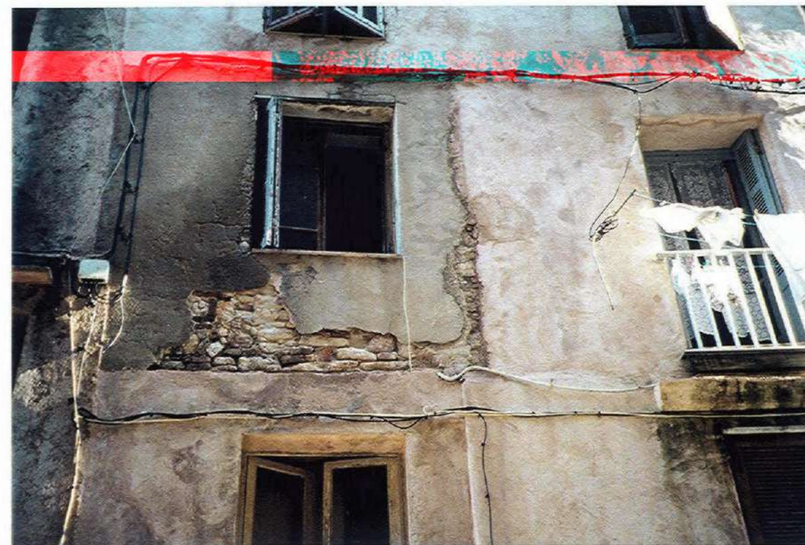
Fenêtre transformée et réinstallée au nu intérieur du mur de façade
