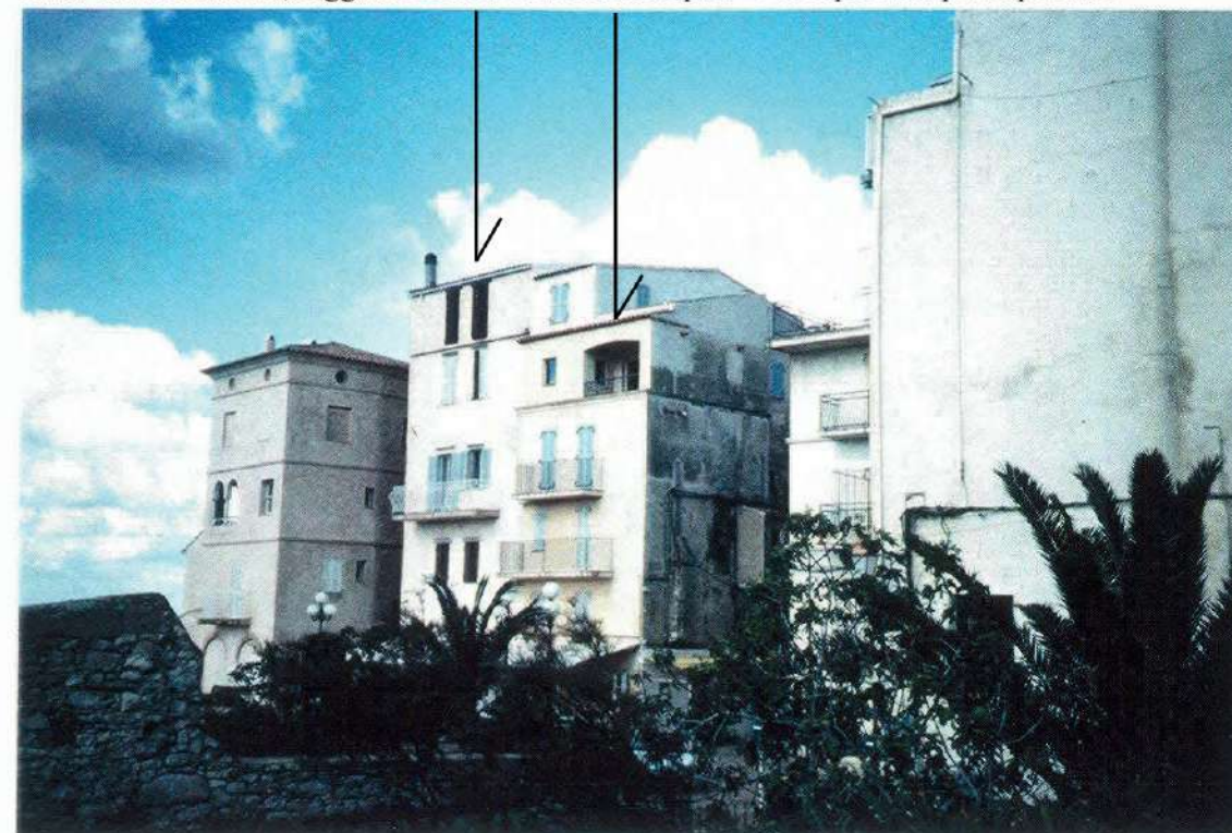
Dans la surélévation, loggias récentes très inesthétiques - Exemple à ne pas reproduire
