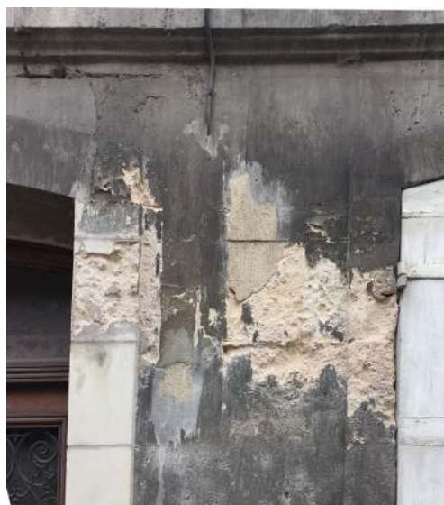
Exemple d'un enduit sur pierre appareillée inadapté (au ciment) = la pierre se désagrège sous l'effet de l'humidité emprisonnée.
