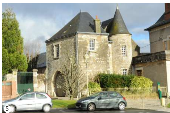
5 Ancienne maison d'arrêt Place Denis Poisson.
