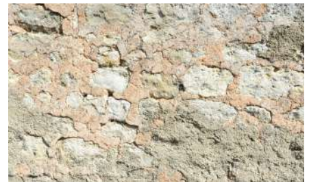
Maçonnerie de moellons calcaire grossièrement appareillés, couvert à pierres vues d'un enduit teinté de brique pilée (visible sur le l'exemple du haut).
