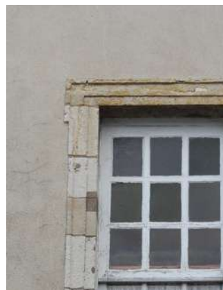
Cadres de baie du château de l'Ardoise en calcaire de Souppes, façade enduite.
