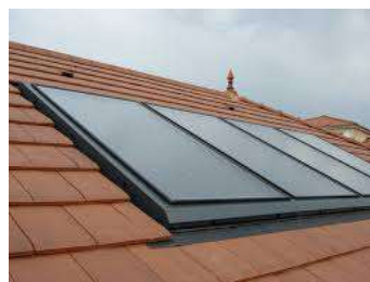
Exemple de capteurs solaires sur toiture tuile.
