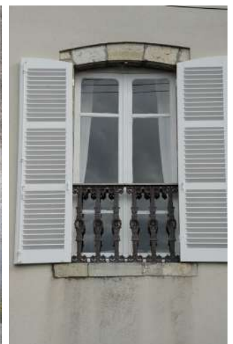
Exemple de fenêtre ancienne avec cadres ouvrants arrondis, détail à ne pas supprimer.
