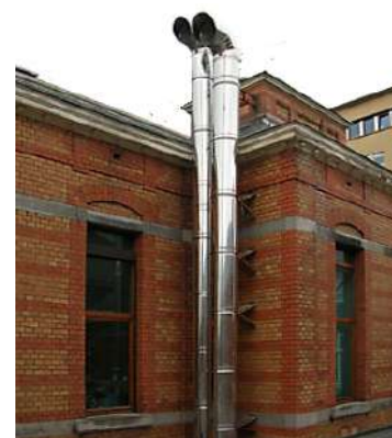
Exemple de conduit de fumée pour chaudière biomasse bois (hors région) source DINAK
