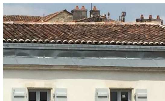
L'isolation des rampants de toiture par l'extérieur au-dessus des chevrons entraîne une surélévation en rive de toiture : dessin de droite.
