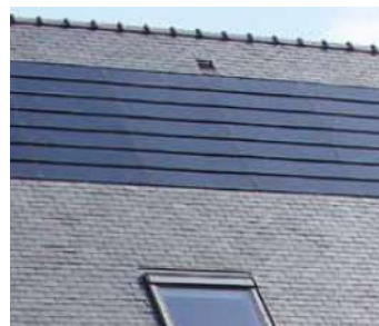
Exemple de capteurs solaires sur toiture ardoise, invisible sous les ardoises
