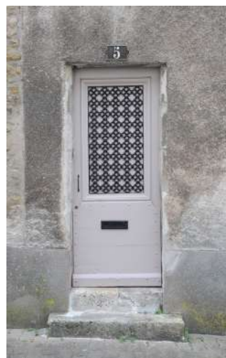
Pithiviers possède un nombre très important de portes anciennes remarquables qu'il est impératif de conserver.
