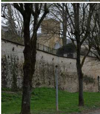
Vue sur le donjon au-dessus du rempart Est.
