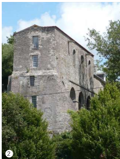
2 Ancien prieuré Saint-Pierre 5 bis impasse Saint-Pierre, lieu-dit l'Abbaye.
