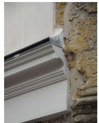
L'encorbellement au-dessus du rez-de-chaussée, et les cadres de baie en bois signalent la structure en pan de bois ; l'immeuble a été recouvert d'un enduit au plâtre gros, avec lequel de larges corniches ont été tirées pour donner à la façade l'esthétique néo-Classique.
