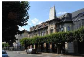
Usine et bureaux Gringoire
