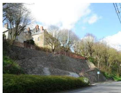
Le double escalier relie le Mail Est et la rue du Parc, en rive gauche de la vallée de l'Œuf.
