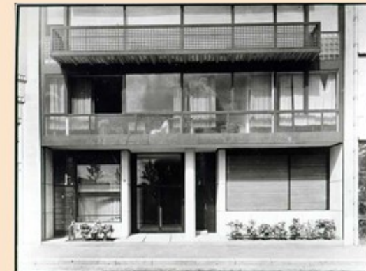
Façade de l'immeuble 24NC © Photos d'Albin Salaün.
