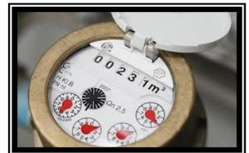
Un test simple peut être réalisé une fois par mois, qui consiste à fermer tous les robinets et de vérifier si la petite ailette du compteur d'eau tourne. S'il n'y a pas de mouvement au bout de quelques minutes c'est qu'il n'y a aucune fuite conséquente.
