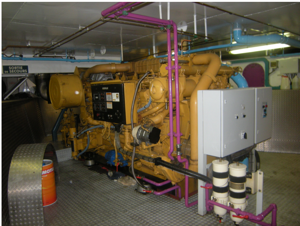
Salle des machines d'un automoteur de 110 m. © MDRF
