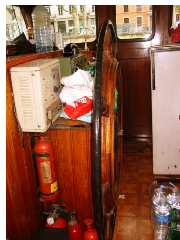
Cabine de pilotage d'un Freycinet. © MDRF
