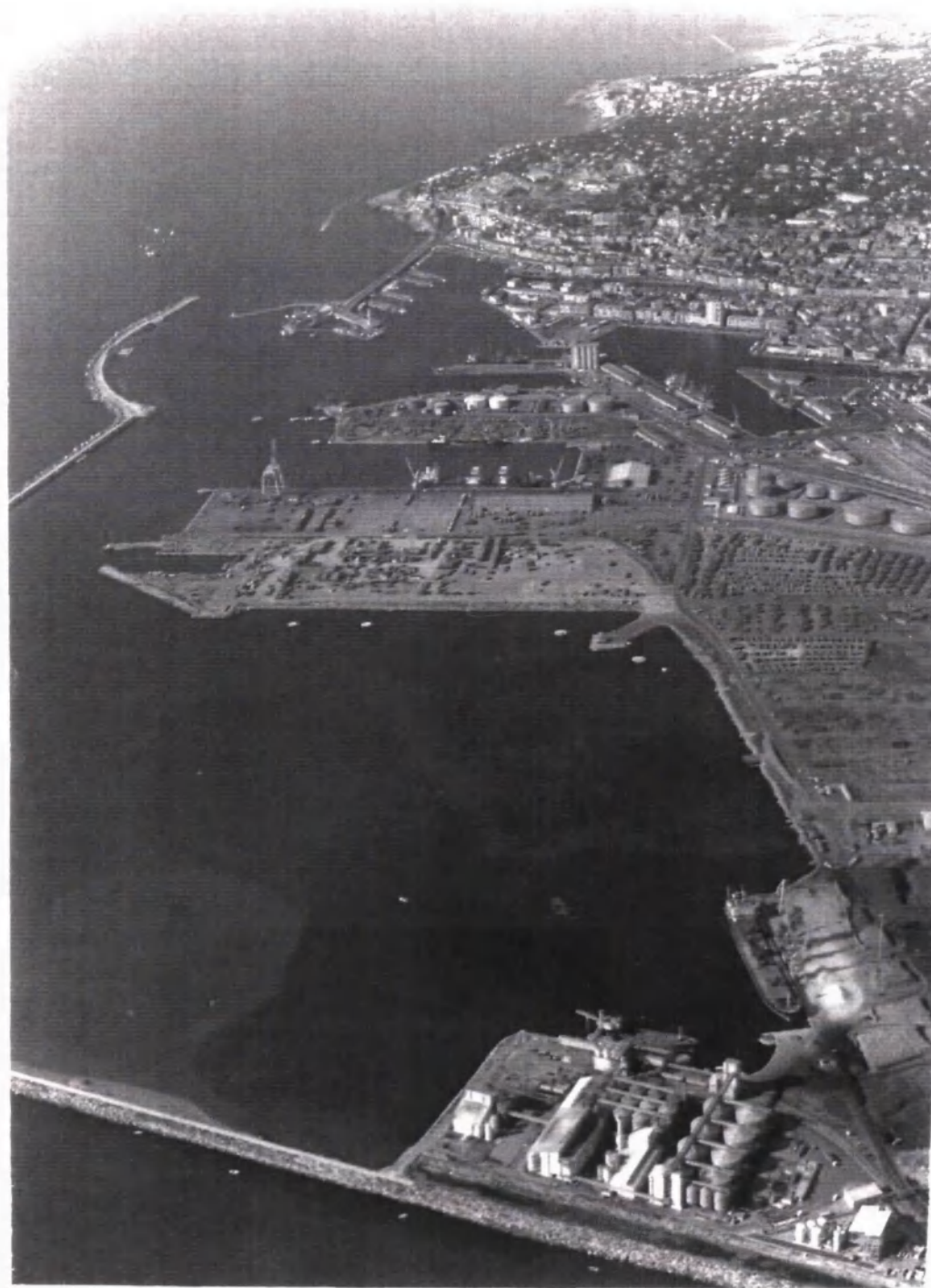
AUJOURD'HUI LA QUASI TOTALITE DES OPERATIONS DE MANUTENTION A LIEU DANS LES NOUVEAUX BASSINS SITUES A L'EST DE LA VILLE
