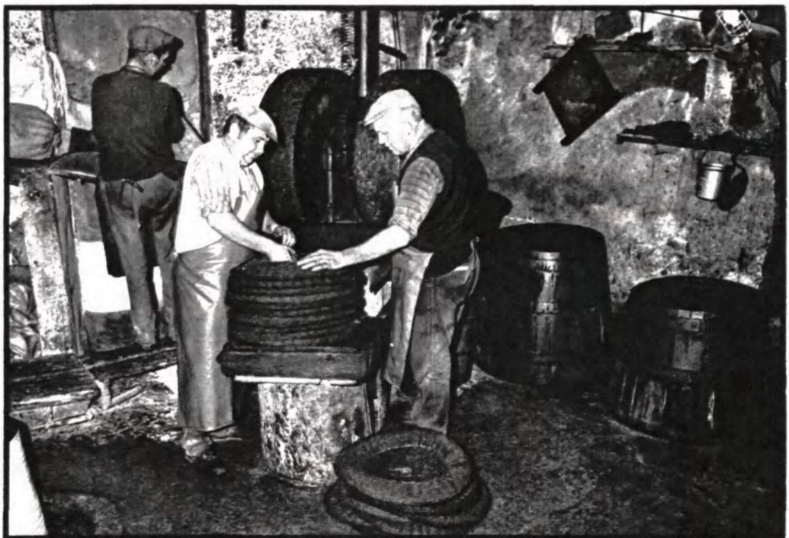
Photo N°36: Moulin à arbre en fer et meules jumelées (Lurs - Alpes de Haute-Provence) (cliché P. RICOU)
