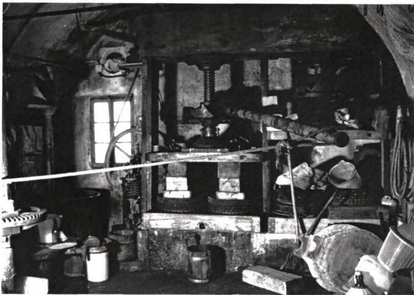
Photo N°43 : Pressoir à l'ancienne avec un cabestan
