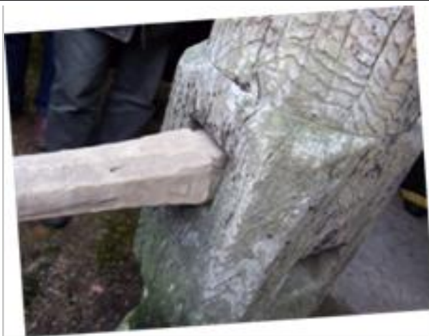
Détail d'un guindas servant de pilier dans un atelier de charpentier à bateaux au bord du canal d'Orléans à Combleux (45). Datant du milieu du XIXe siècle, le bâtiment est construit avec du bois issu de bateaux déchirés. Inscription à l'Inventaire IA45000002. Cl. Ellébore.
