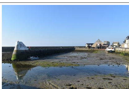
Ill. 2. Vue du Chantier naval Bernard de Saint-Vaast-la-Hougue depuis la cale, 18 juin 2021. © Théo Lebouc, 2021.
