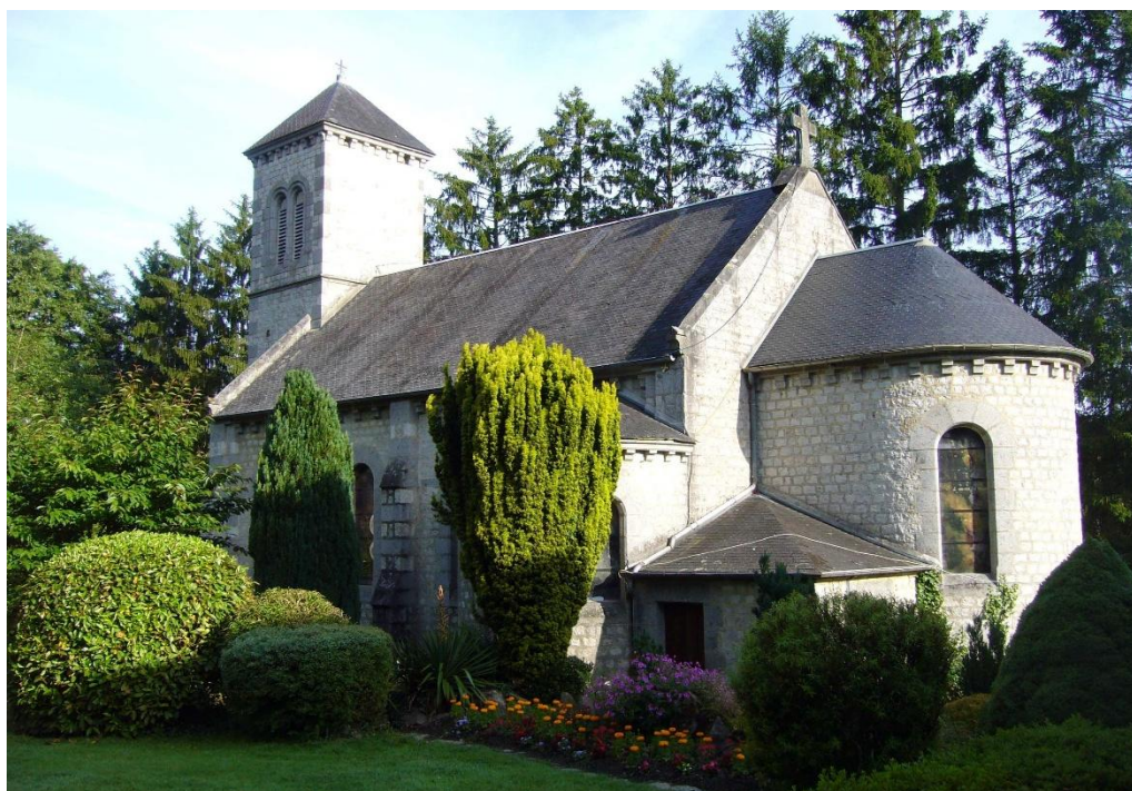
Vue générale sur la chapelle Saint-Ortaire, propriété des Servites de Marie, dans le jardin lui servant d'écrin
