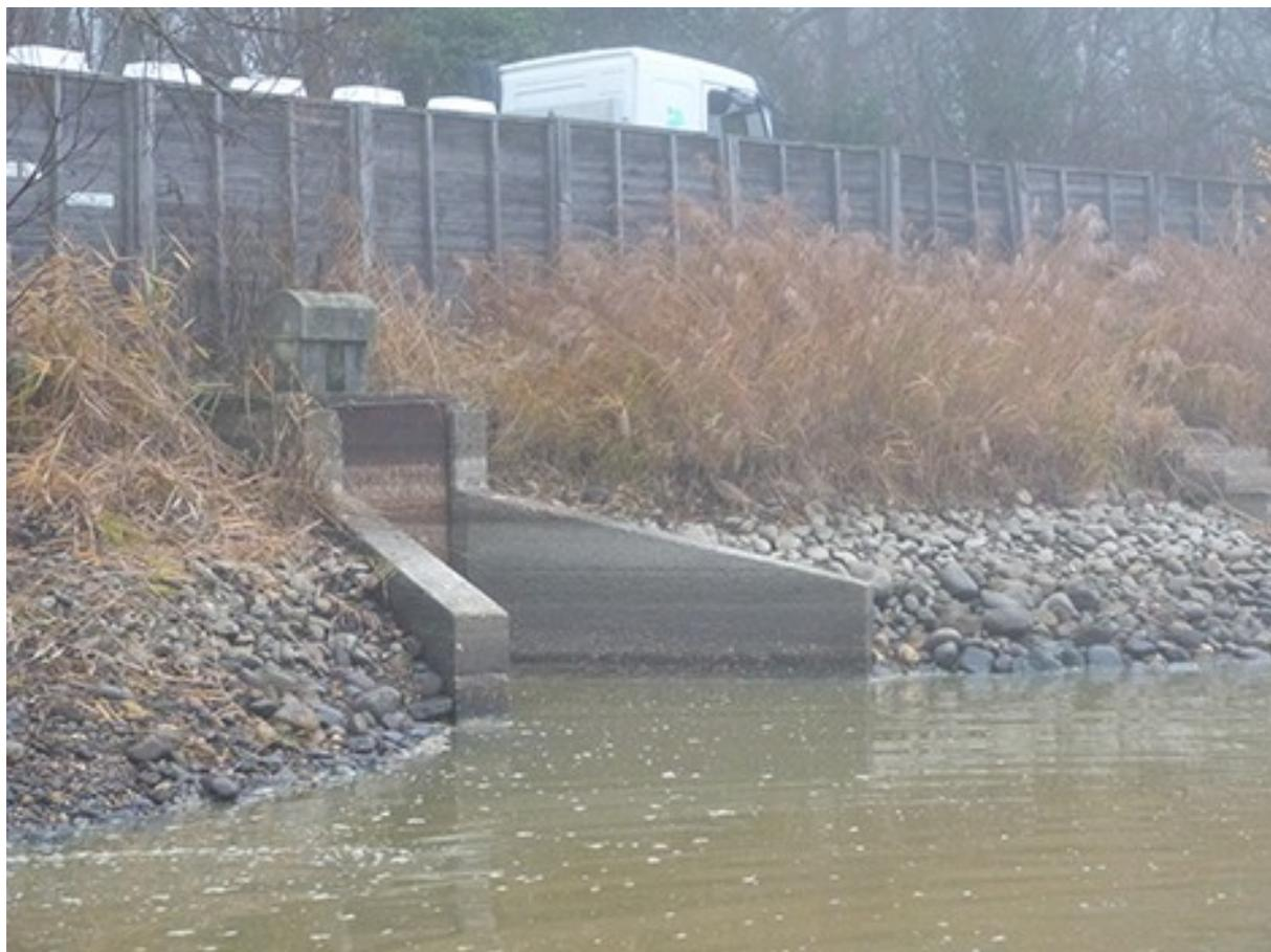
Cet ouvrage, autrefois en bois, aujourd'hui en ciment, est un système de vidange qui permet de retenir ou de lâcher l'eau à volonté grâce à la bonde dont il est équipé. Chaque partie du **thou** est identifiée : l'**empellement** (ouvrage permettant de barrer ou laisser s'écouler l'eau), la **dagne** (barre de fer à l'extrémité de laquelle se trouve la bonde), la bonde, la grille (grille en avant du thou permettant de filtrer l'eau).
