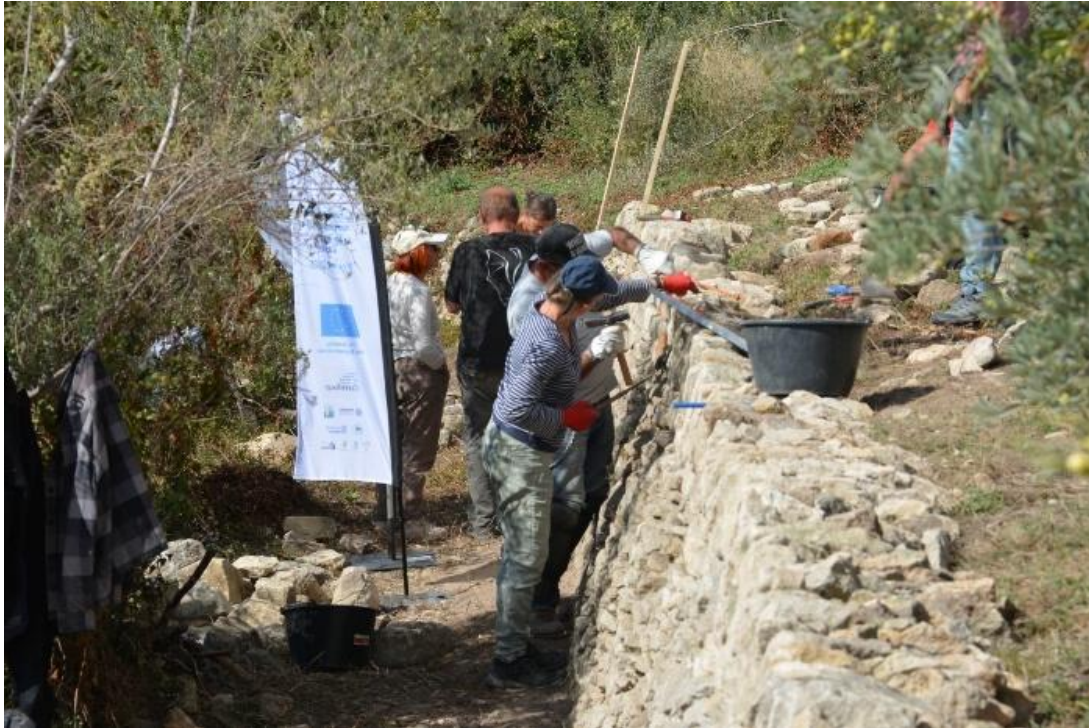
Réfection d'un mur de soutènement à l'espace naturel sensible de Caromb (84) dans le cadre du stage en septembre 2025, qui a réuni des acteurs d'associations, des paysagistes et des architectes. © Volubilis.
