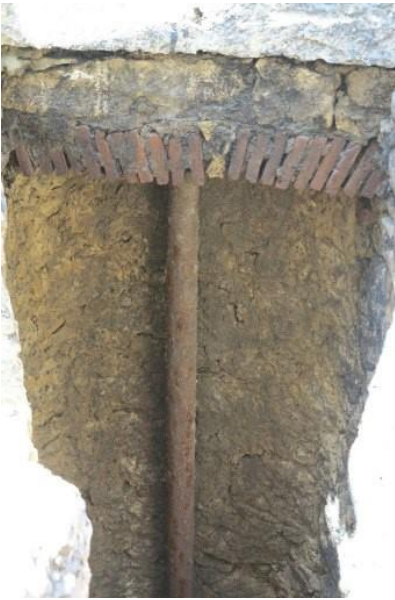
Fig. 7 - Détail de l'élévation ouest.
