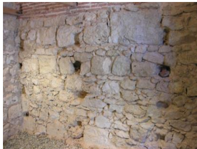
Fig. 2 - Partie production : intérieur d'une des deux étuves (trous pour les perches).
