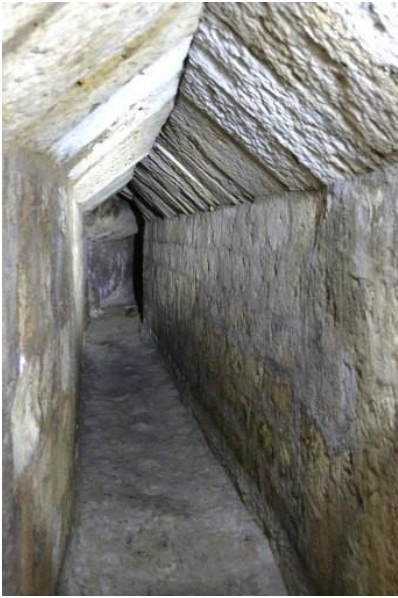
Fig. 22 - Le couloir-aqueduc (vue ouest).
