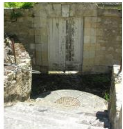
Fig. 27 - Partie administrative : porte nord.
