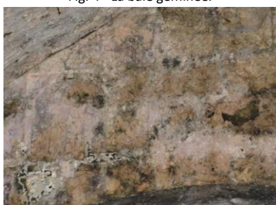
Fig. 7 - Mur situé entre les deux voûtes : détail la peinture. (vue Est).
