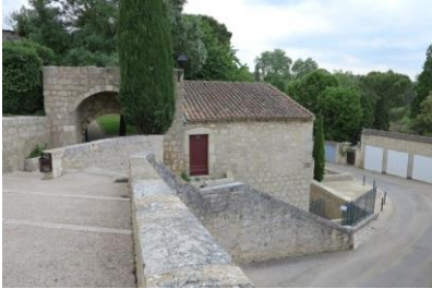
Fig. 13 - Elévation ouest (vue nord-ouest).
