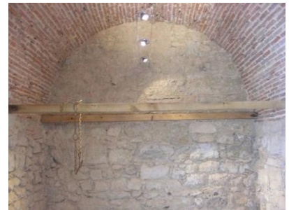
Fig. 3 - Partie production : voûte en brique d'une des deux étuves.
