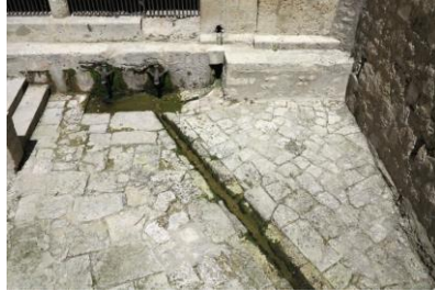
Fig. 14 - Le sol du trop-plein (vue sud).
