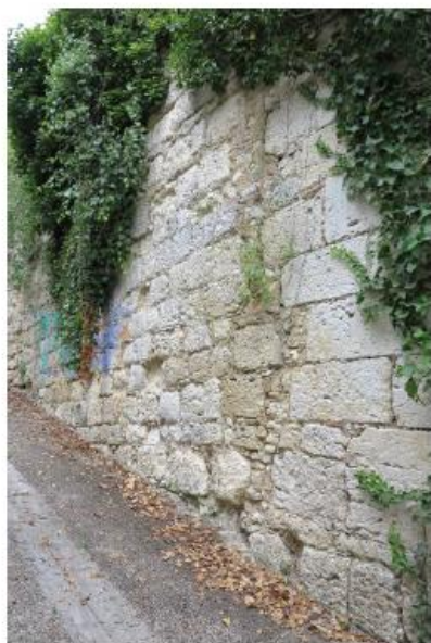
Fig. 10 - Angle sud-ouest de la clôture (deux appareils de maçonnerie distincts).
