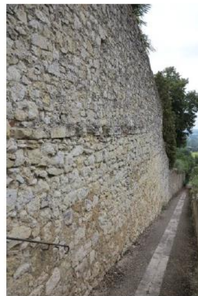
Fig. 9 - Mur de clôture ouest et carrelot (vue nord).
