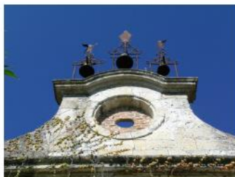
Fig. 14 - Partie administrative : fronton du porche du bâtiment principal (vue sud).
