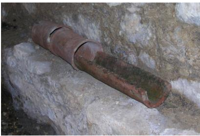
Fig. 1 - Une conduite en terre-cuite.
