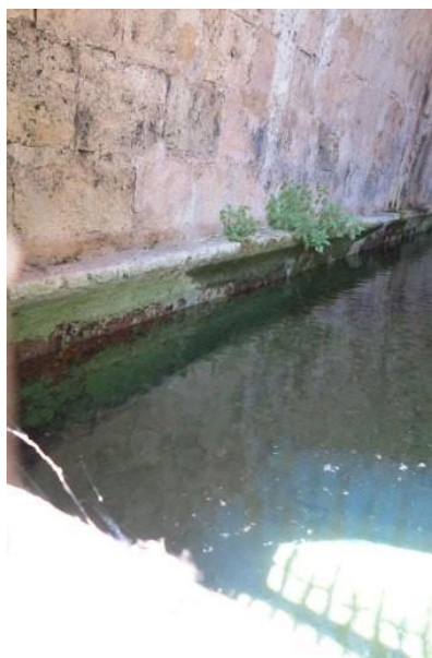
Fig. 20 - La maçonnerie en grès rose foncé du bassin.
