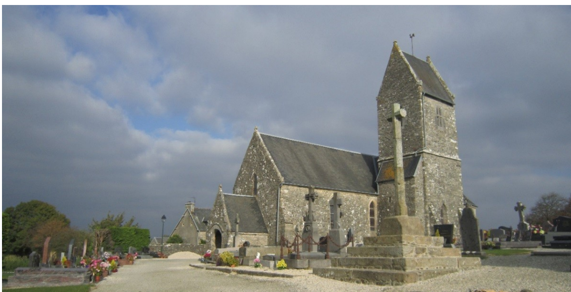
Vue de l'église depuis l'entrée sud du cimetière
