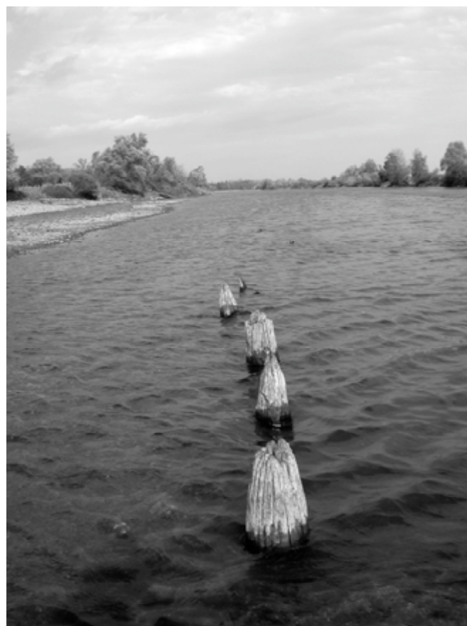
Fig. 100. Avrilly, fleuve Loire. Une rangée de pieux visibles en période de basses eaux dans le lit de la Loire. Les parties qui émergent sont très érodées (cl. A. Dumont).
