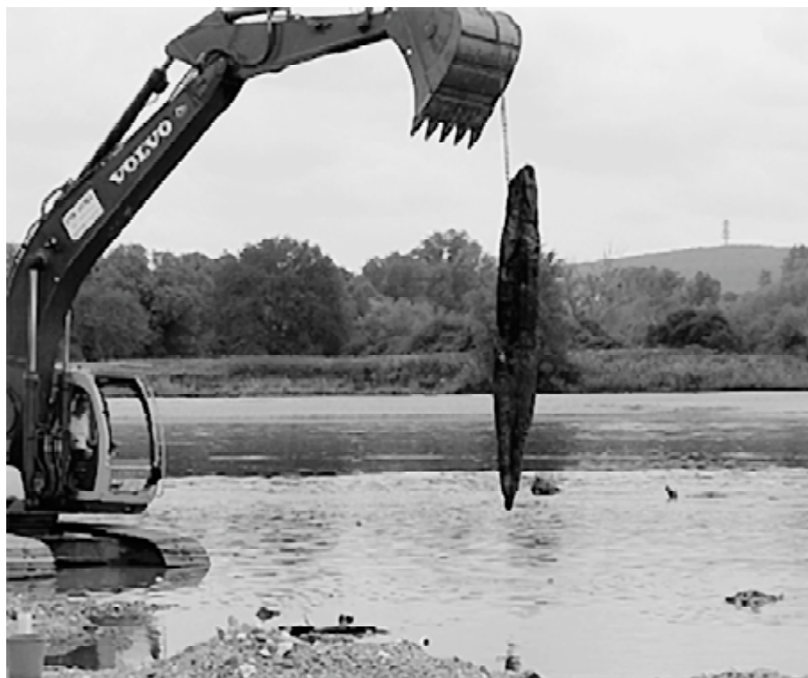
Fig. 83. Saint-Satur, fleuve Loire. Extraction d'un pieu de fondation d'une pile du pont en pierre à l'aide d'une pelle mécanique (cl. F. Laudrin).
