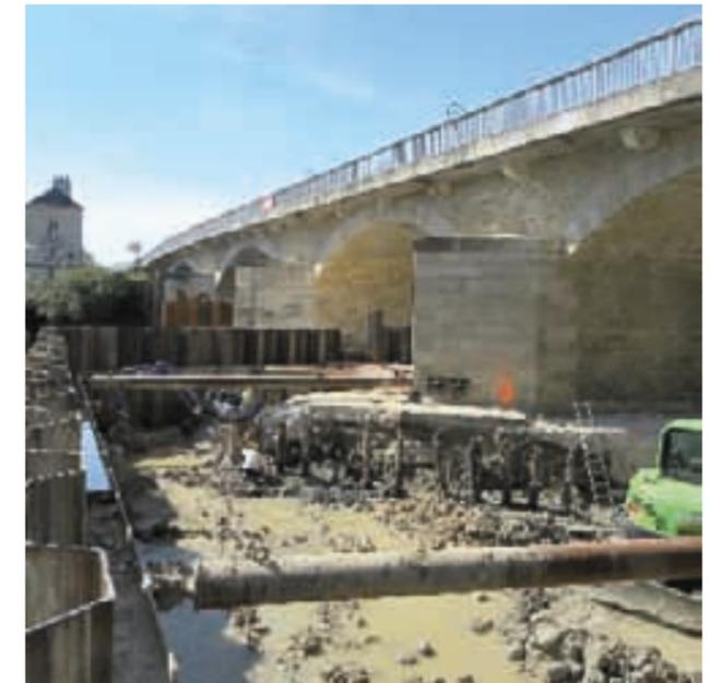
Fig. 134. Fondation d'une pile et file de pieux d'un ancien batardeau.
