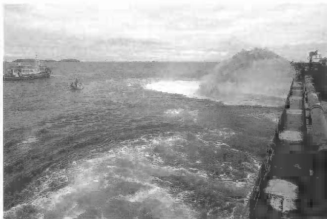
Fig. 16. Déversement de 250 tonnes de sable sur le site des épaves par le sablier *Côtes-d'Armor* (cl. F. Osada, Images Explorations).
