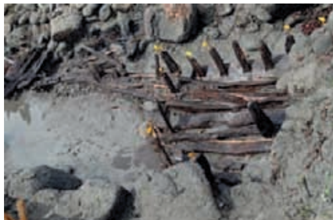
Fig. 6. Le renfort A de la panne est-ouest.
