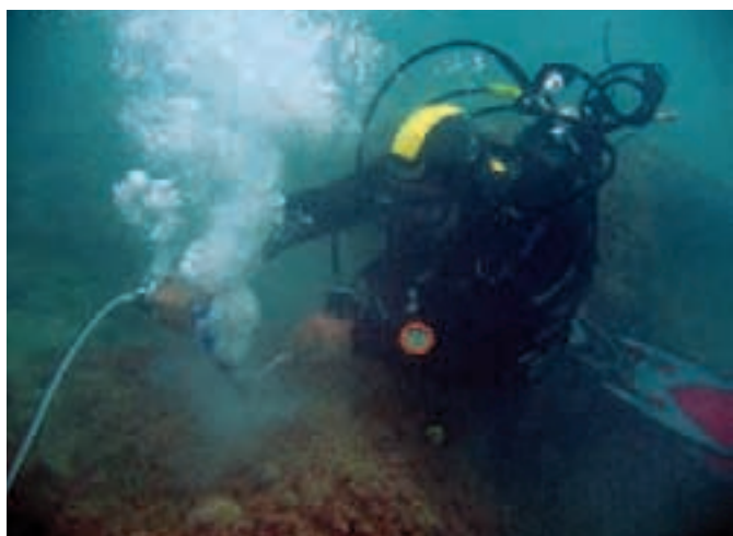
Fig. 73. Utilisation du système de burineur pneumatique pour le perçage (cl. S. Morabito, SAVN).
