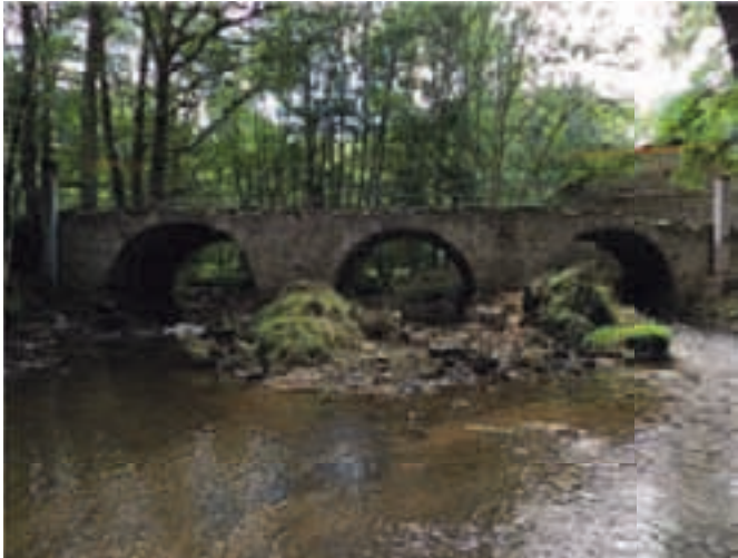
Fig. 154. Vue de la face aval du pont (cl. I. Pignot © Éveha).
