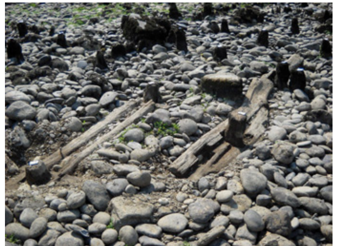
Fig. 53 : Marquefave, digue-barrage du moulin de Saint-Hyppolite, assemblages traverses-pieux (cl. J.-M. Lassure)
