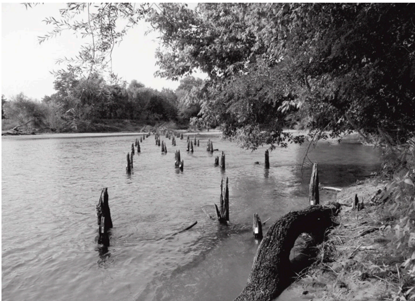
Fig. 47 : Les pieux du pont médiéval entre La Charité-sur-Loire et La Chapelle-Montlinard en période de basses eaux (Cl. P. Moyat)
