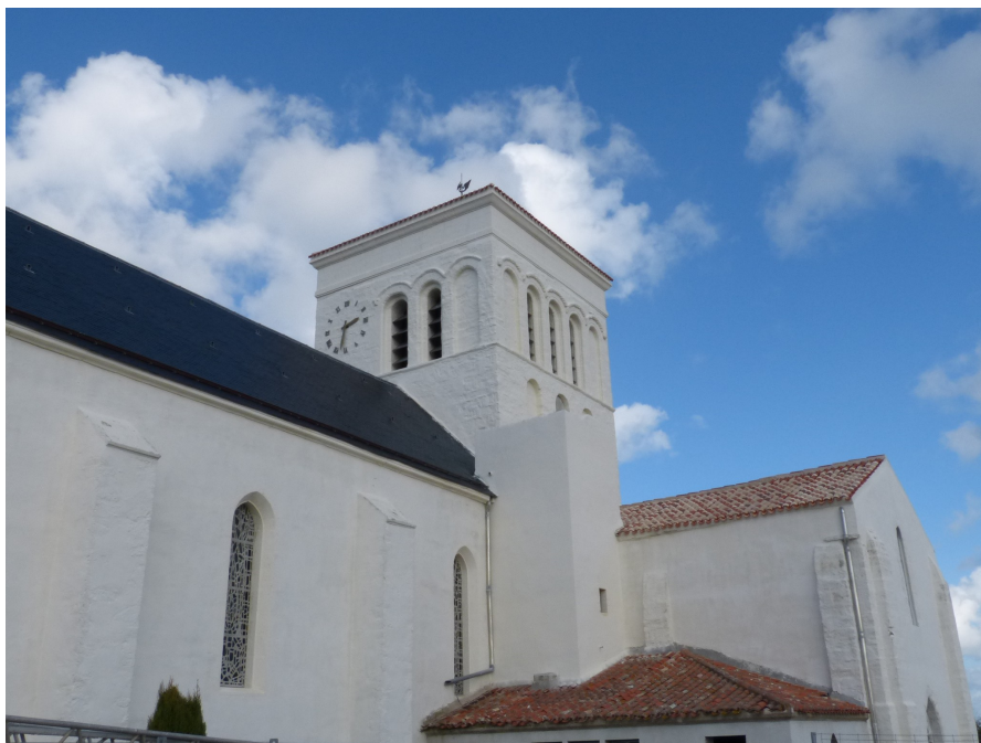
Les façades extérieures de l'église Saint-Sauveur après restauration
